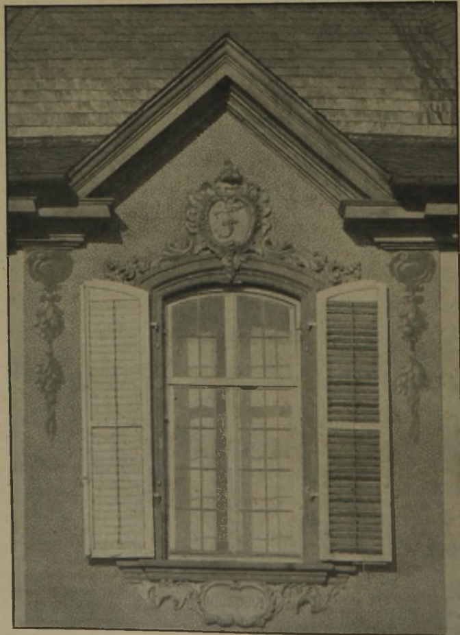
Abb. 7. Einzelheit am Verbindungsbau. Fenster-Überdachung. Das Schloß zu Bruchsal.
