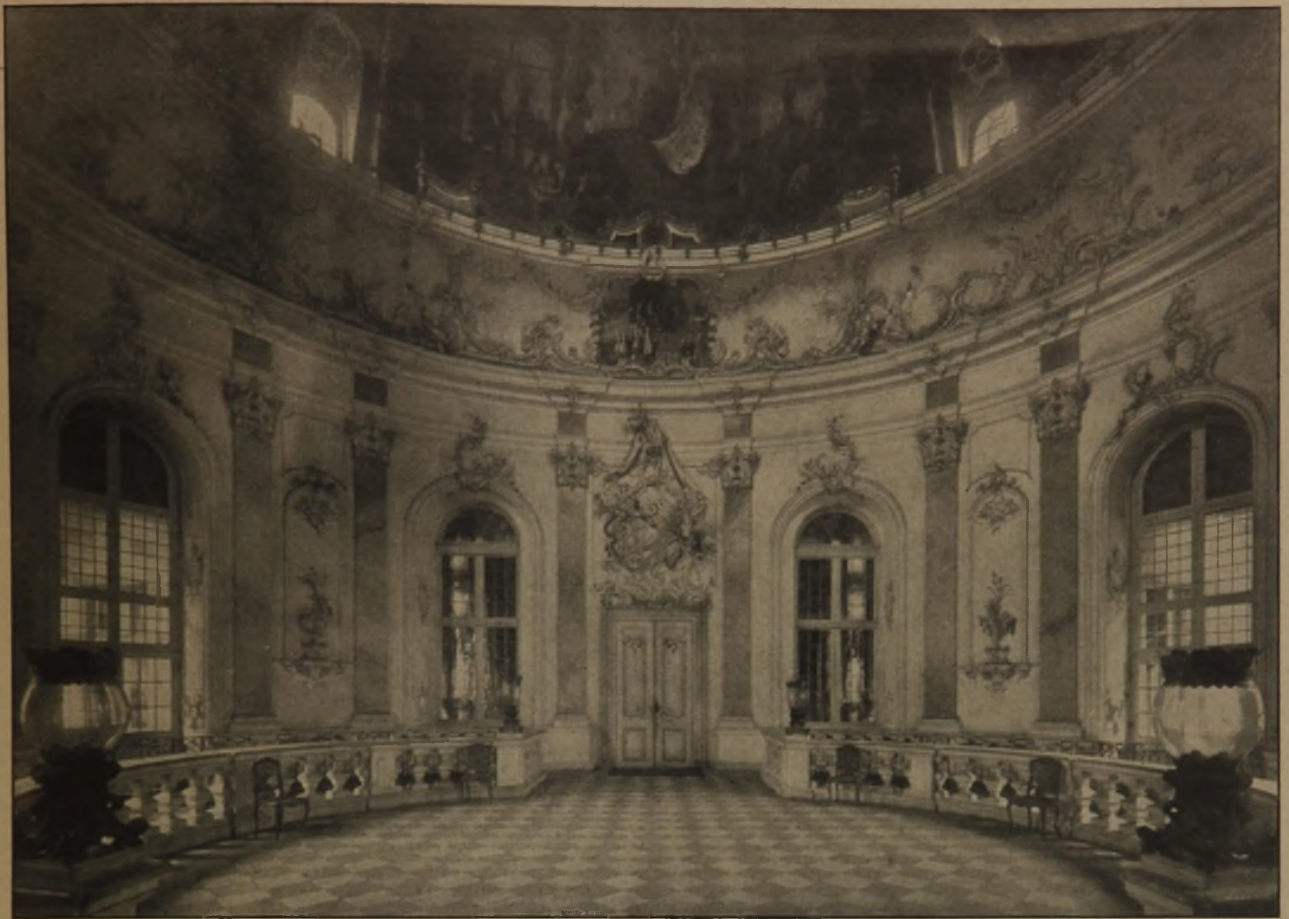
Abb. 8. Blick in das Treppenhaus.
