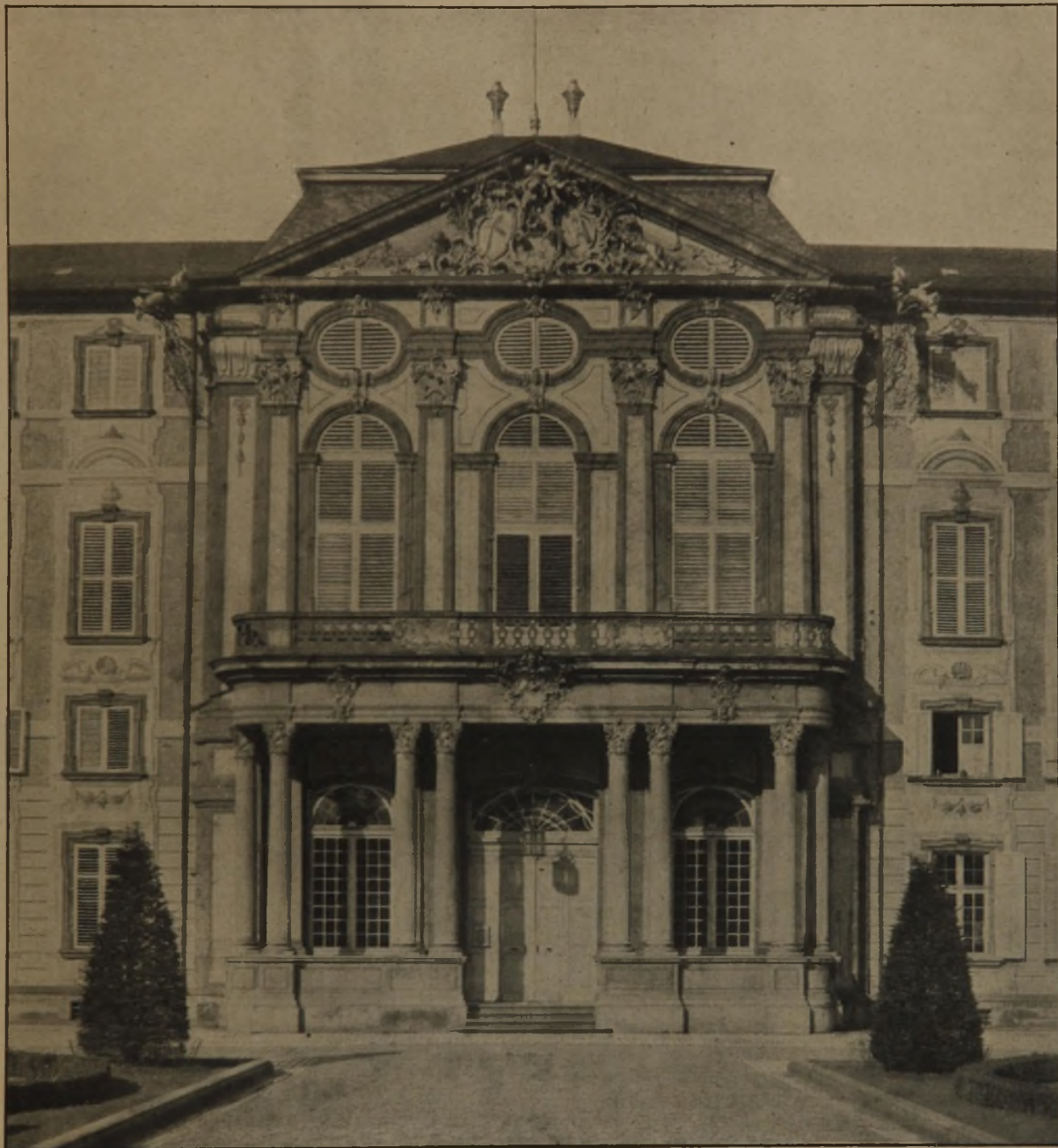
Abb. 3. Mittelbau der Hauptfassade des Corps de Logis.
