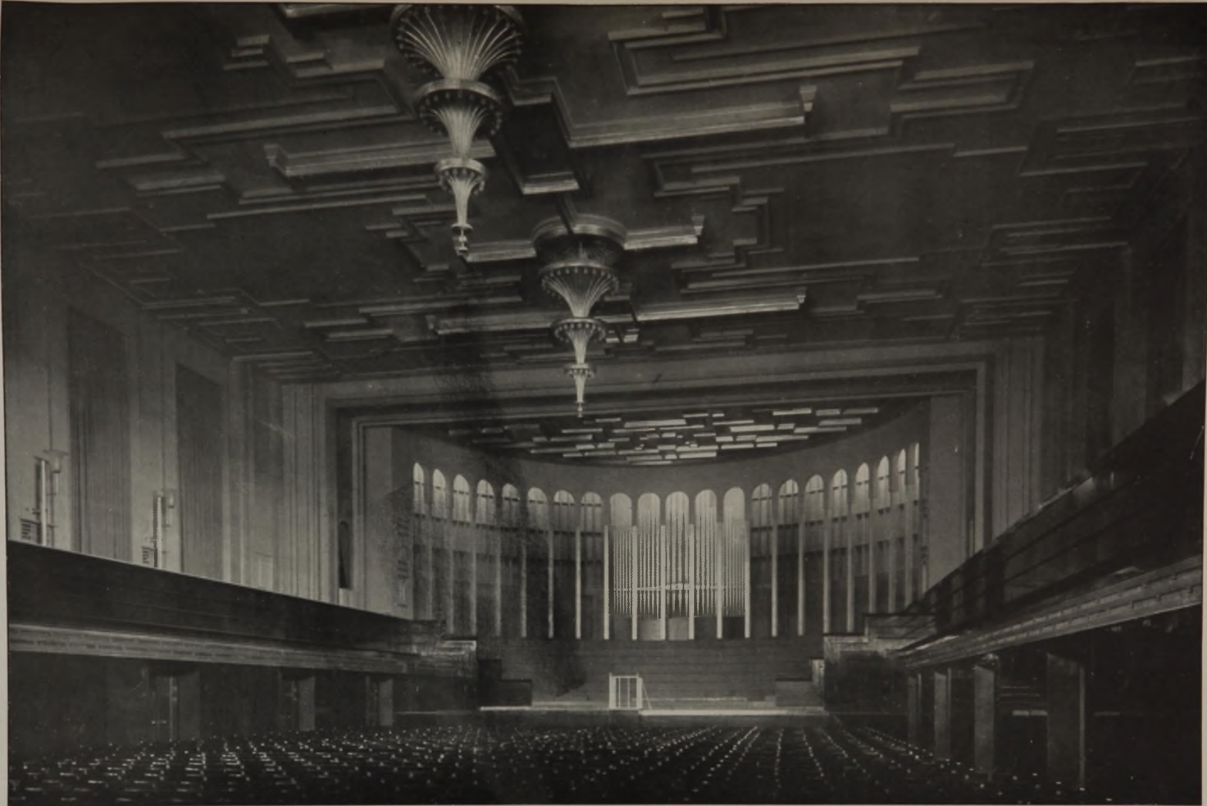
DIE NEUE STADTHALLE IN MÜLHEIM-RUHR / GROSSER FESTSAAL BLICK GEGEN PODIUM BEZW. BÜHNE ARCHITEKT: PROF. E. FAHRENKAMP IN DÜSSELDORF DEUTSCHE BAUZEITUNG LX. JAHRGANG 1926. NR. 21
