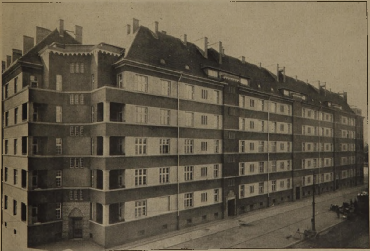
Abb. 21. Hauptansicht an der Dreibundstraße. Arch.: Walter Borchard, Berlin. Die neuen Wohnhausbauten der Berliner Straßenbahn.
