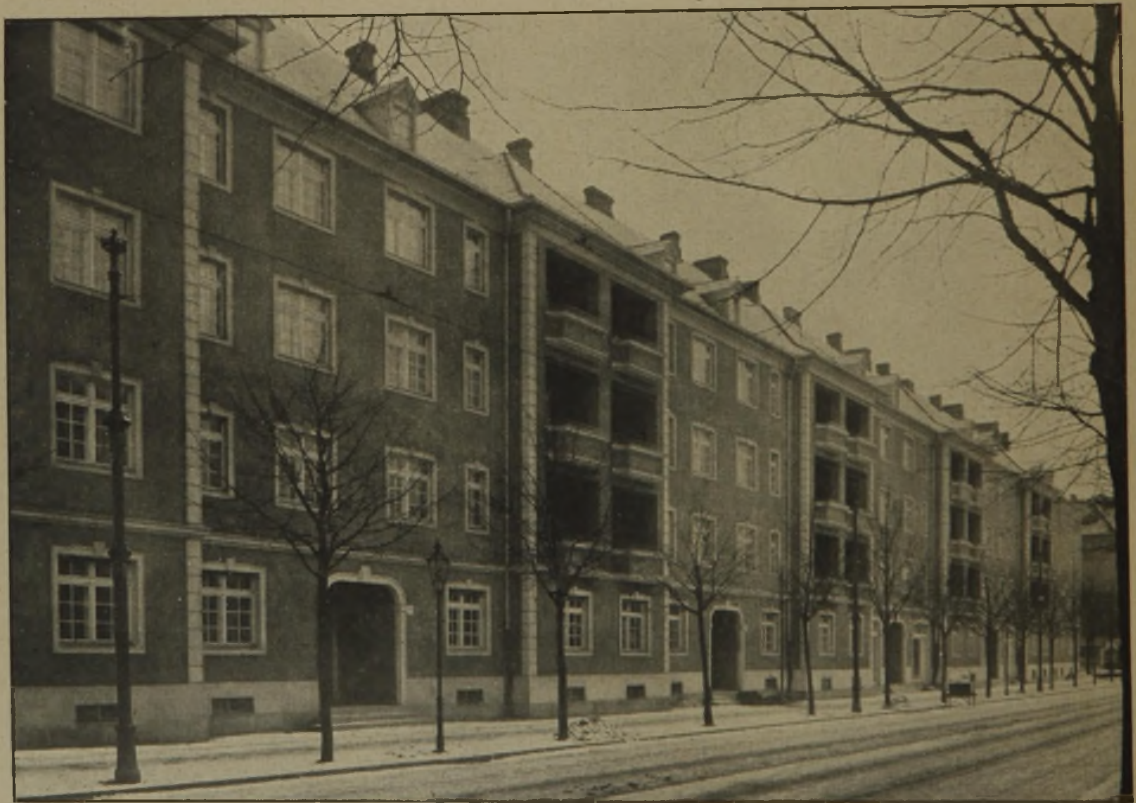
Abb 33. Ansicht an der Siegfriedstraße. Wohnhausgruppe Lichtenberg, am Freyaplatz. Architekt: Dr.-Ing. Grisebach, Berlin.
