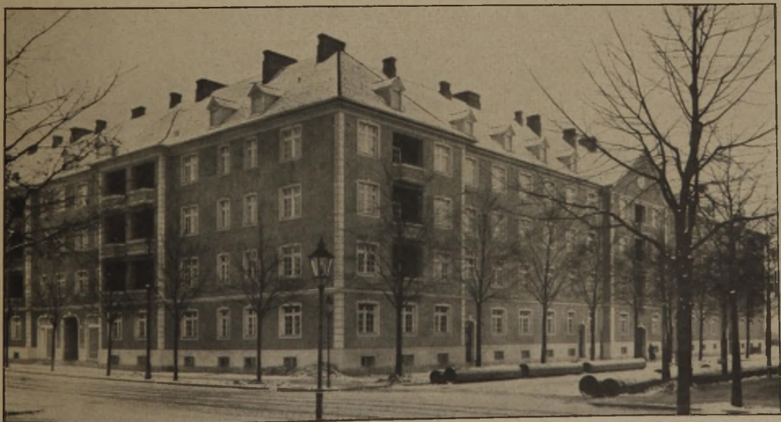
Abb. 35. Ansicht an der Siegfried-, Ecke Rüdigerstraße. Wohnhausgruppe Lichtenberg, am Freyaplatz. Architekt: Dr.-Ing. Grisebach, Berlin.
