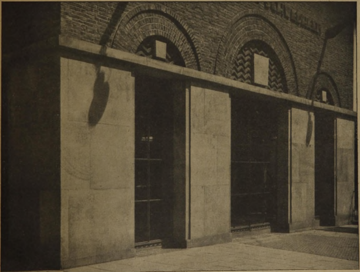
Abb. 10. Unterbau mit Eingang. Arch. B. D. A. H. Stoffregen in Bremen. Ausstellungsbau am Bahnhof zu Bremen.
