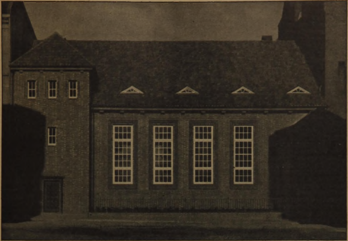
Abb. 1. Außenansicht der Turnhalle.
