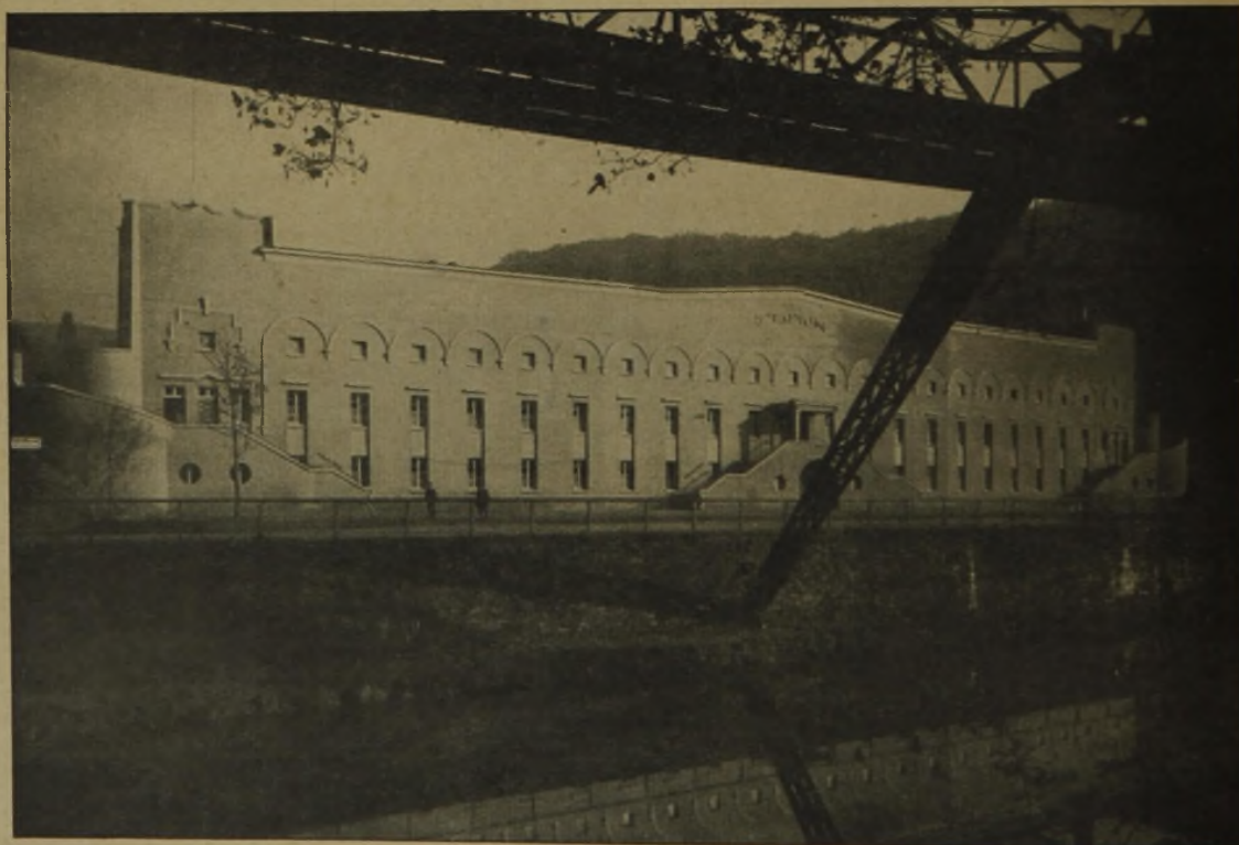
Abb. 9. Tribünenfassade an der Wupperseite. Architekten: Willkens u. Nußbaum in Köln. Das Bergische Stadion zu Elberfeld.
