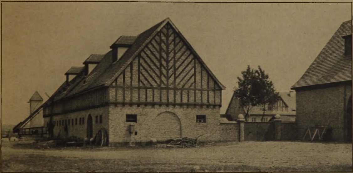
Abb. 8. Rindviehstall mit einer Nebeneinfahrt. Im Hintergrund das Wohnhaus für den Verwalter.
