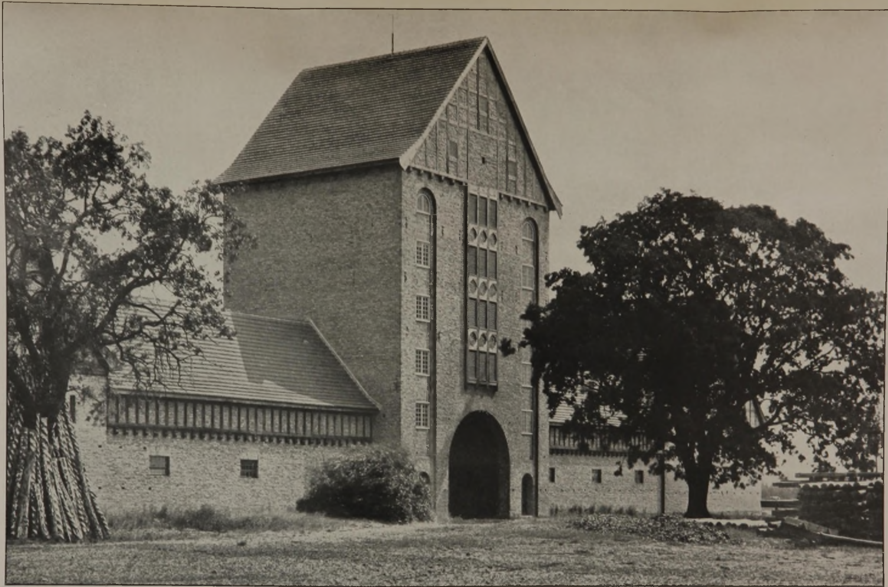
DER DIETERSHOF BEI ALT-RUPPIN I. D. MARK BLICK AUF DEN GETREIDESPEICHER UND SCHUPPEN ARCHITEKT: PROFESSOR ERNST SCHNECKENBERG, B. D. A., BERLIN-CHARLOTTENBURG DEUTSCHE BAUZEITUNG. LX. JAHRGANG 1926. NR. 31
