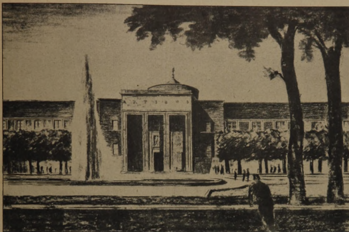
Abb. 9. Neue Fassade des alten Kunstpalastes.
