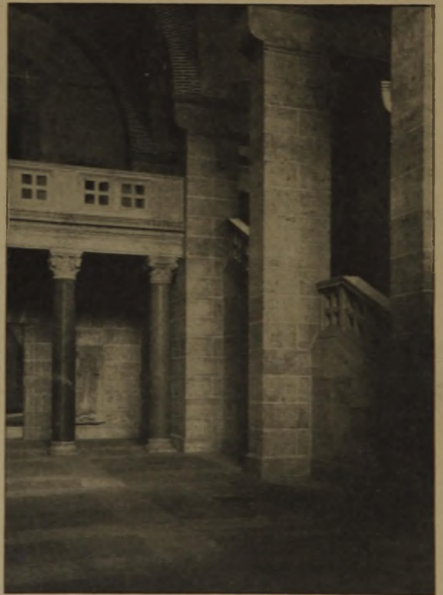
Abb. 16. Eingangshalle mit Ausgang zum Obergeschoß.
