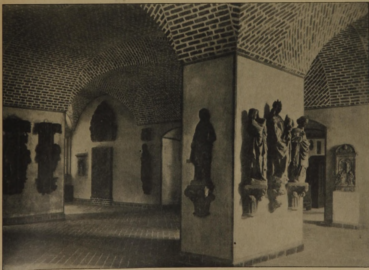
Abb. 1. Blick in das Lapidarium.
