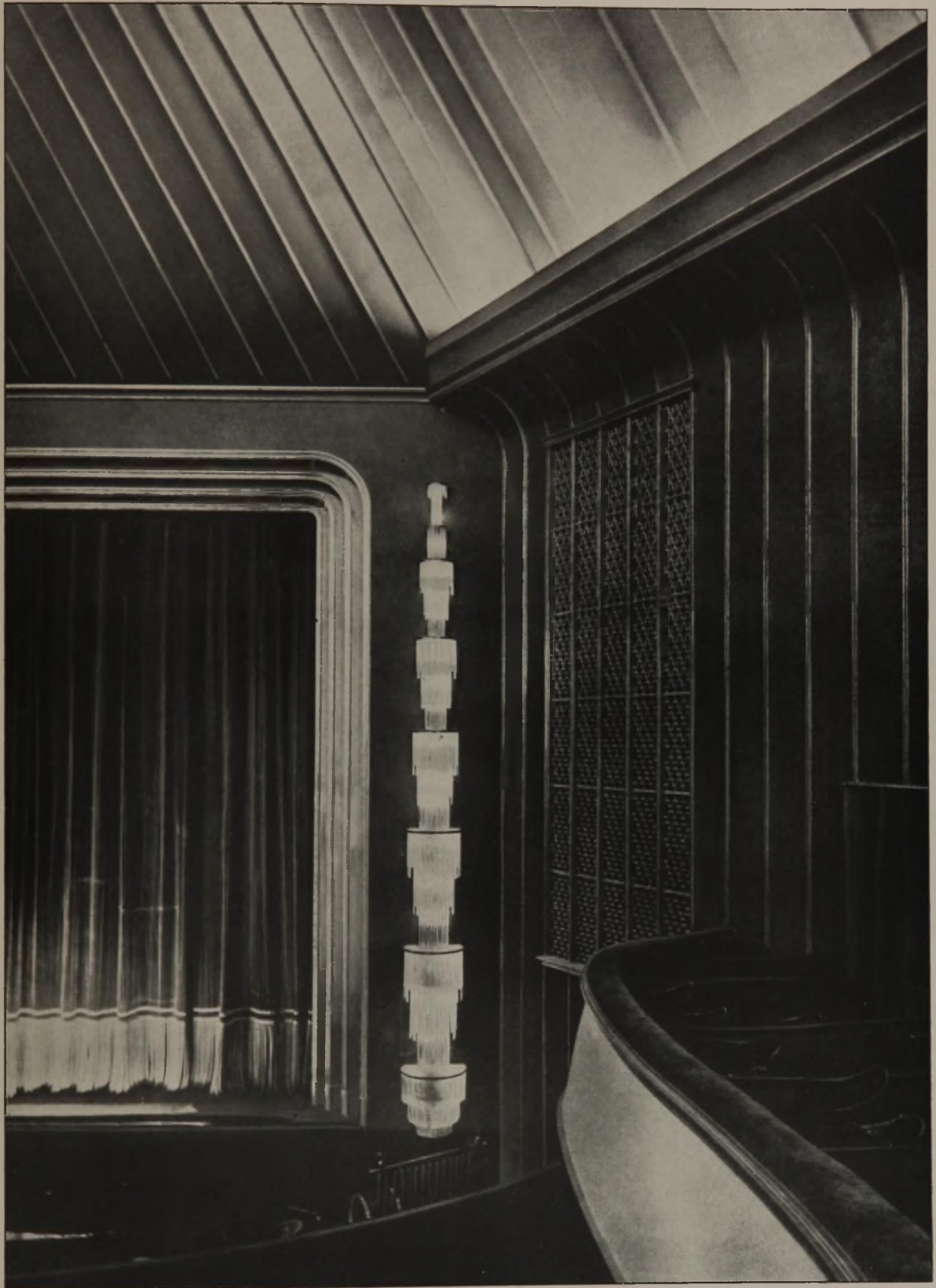
DAS BERLINER FILMTHEATER „CAPITOL“ BLICK NACH DER BÜHNE VON DER EMPORE ARCHITEKT: PROFESSOR HANS POELZIG, POTSDAM-WILDPARK DEUTSCHE BAUZEITUNG. LX. JAHRGANG 1926. NR. 43
