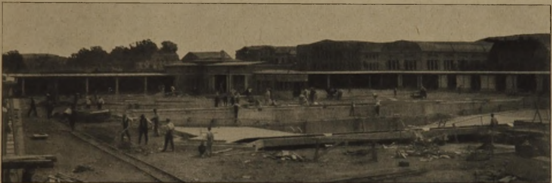
Abb. 5. Schwimmbecken, während der Ausführung.
