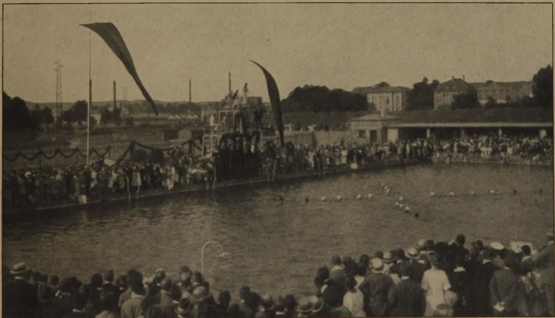
Abb. 6. Schwimmbecken mit Springturm. Das städtische Sommerbad in Gera.
