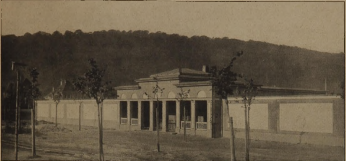
Abb. 4. Offene Eingangshalle mit Kassenanlage.
