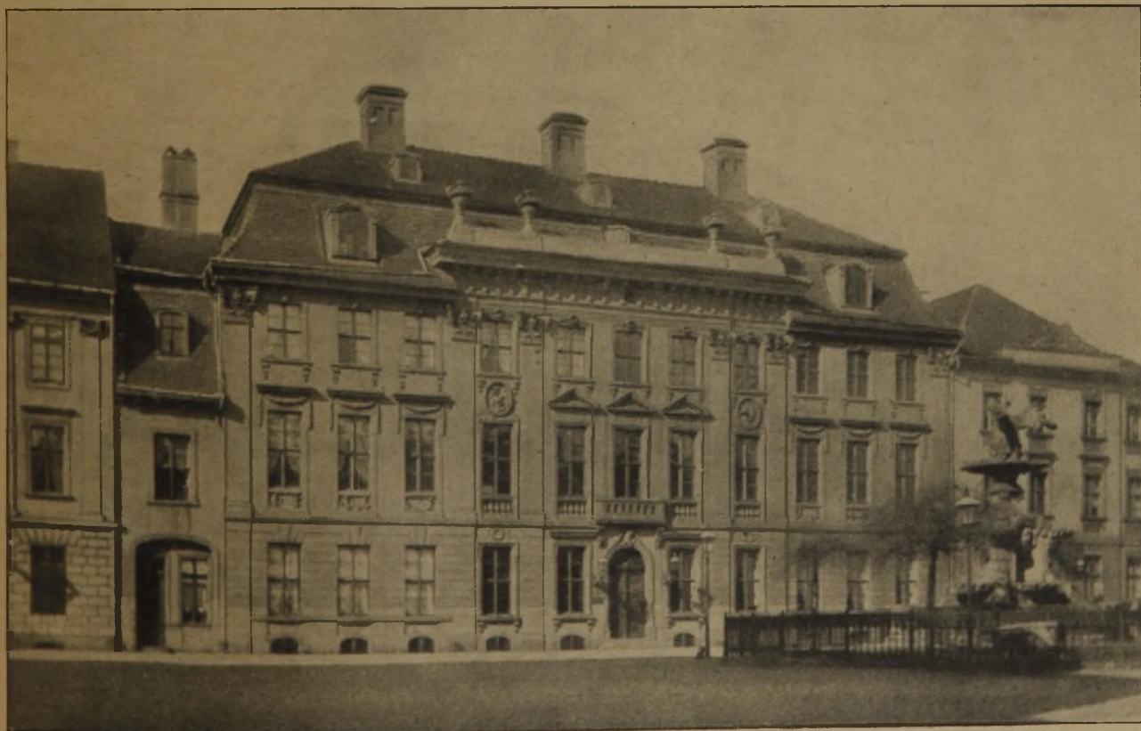
Abb. 1. Neue Fassade des Wietzlow'schen Hauses. Ende 18. Jahrh. Von D. Christlieb Meyer. (Abgerissen).
