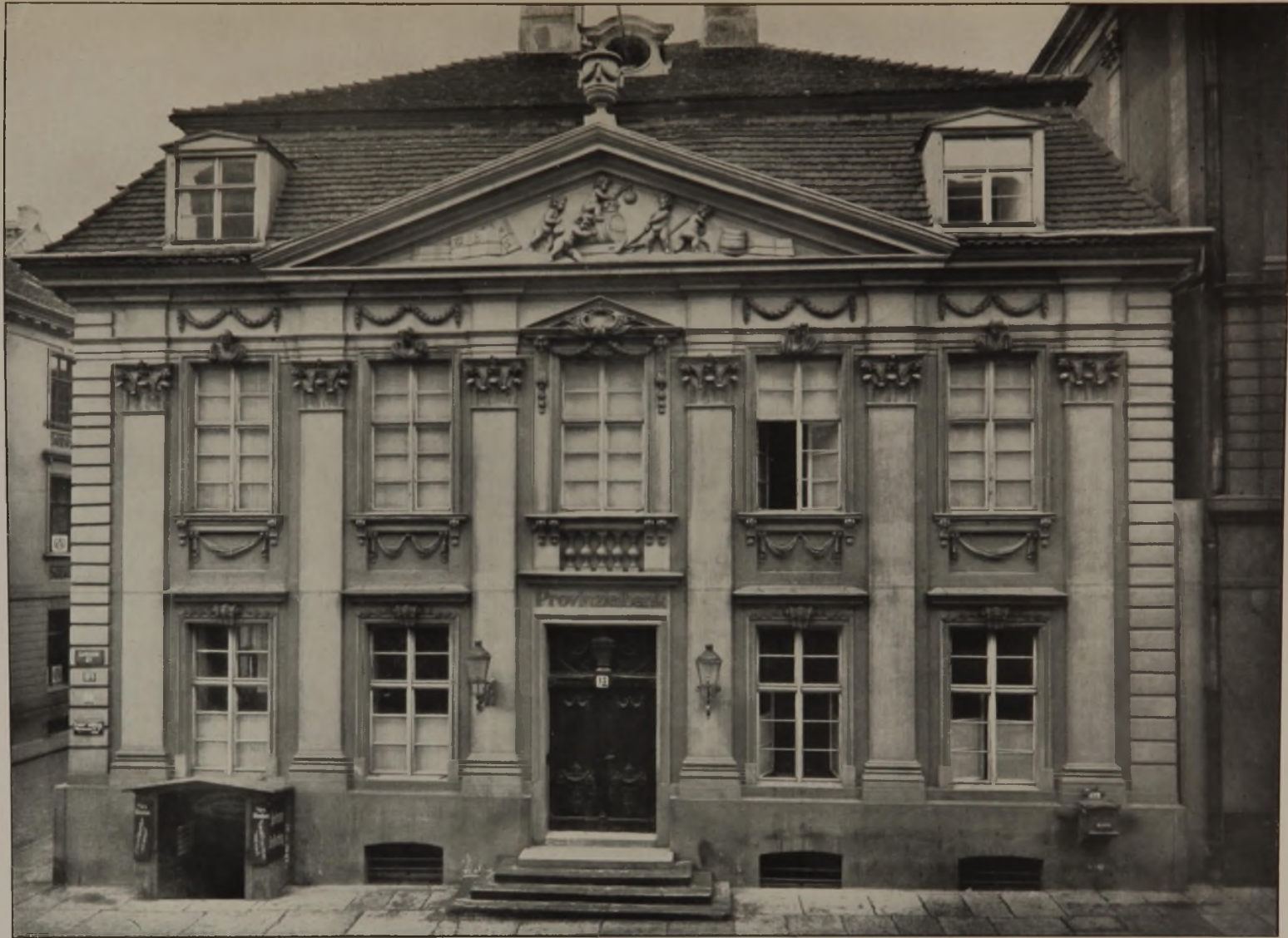
STETTINER BAUKUNST UM ACHTZEHNHUNDERT / HAUS LUISENSTRASSE 13 ARCHITEKT: DAVID CHRISTLIEB MEYER / ERBAUT UM 1795 / PHOT. SEELIG, STETTIN DEUTSCHE BAUZEITUNG. LX. JAHRGANG 1926. NR. 47
