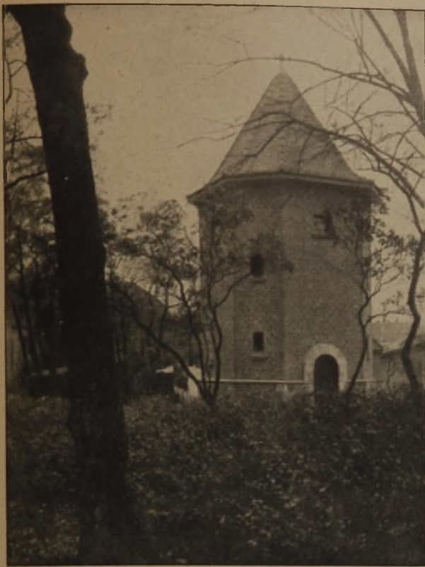
Abb. 3. Waren. Umformer Mitte.
