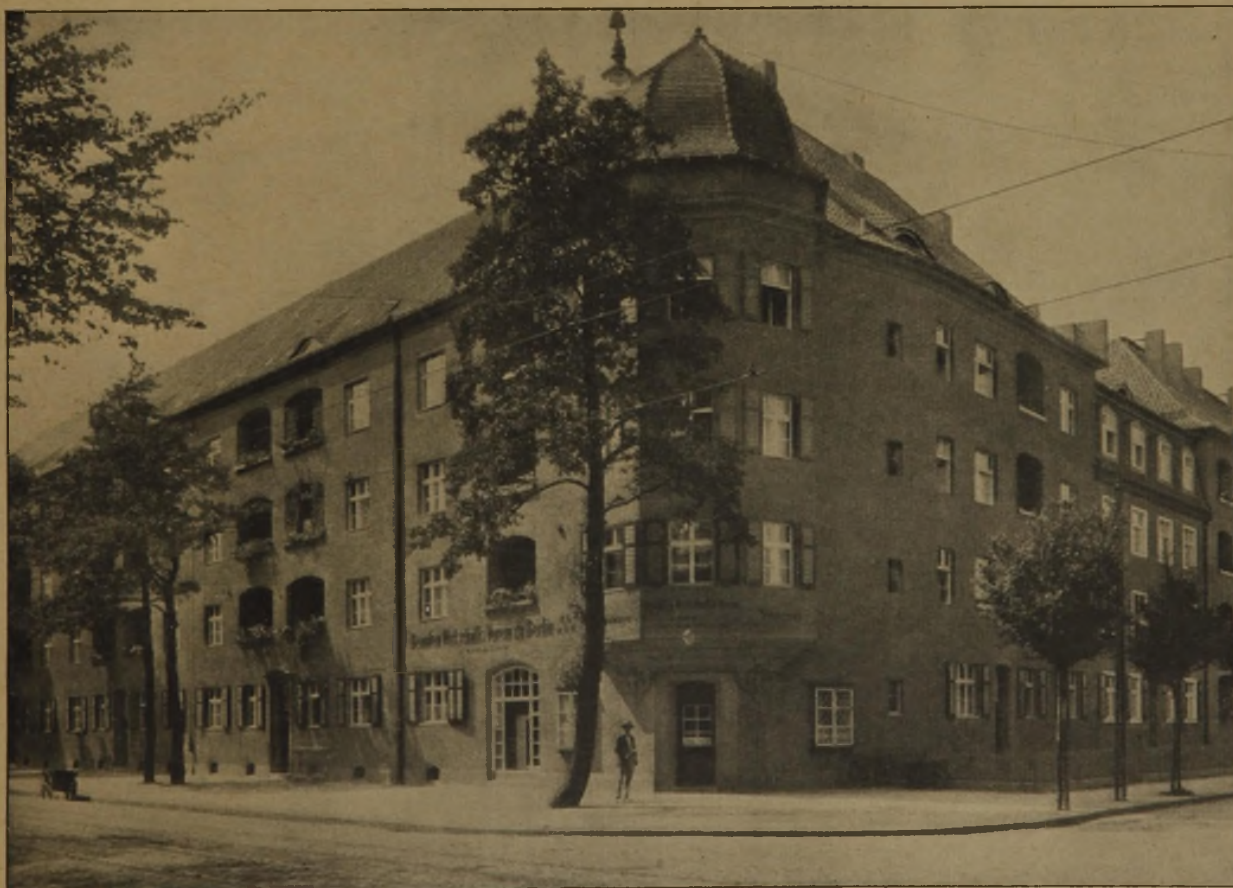
Abb. 1. Bauteil X. Bahnhofstraße, Ecke Stubenrauch-Straße. (Plan Abb. 20, S. 431, Grundrisse Abb. 15—19.) (Sämtliche Aufnahmen aus der Photogr. Werkstatt von Willi Scholz, vorm. Gebr. Graefe, Berlin.)
