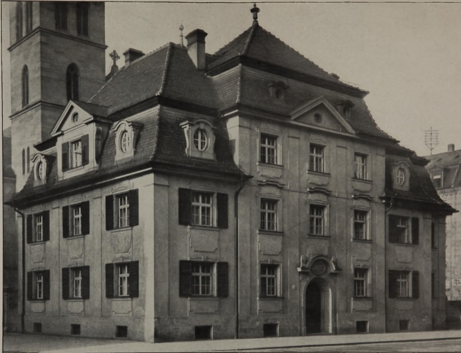
FRÄNKISCHE PFARRHÄUSER / PFARRHAUS HERZ-JESU ZU NÜRNBERG ARCHITEKT B. D. A. PROFESSOR OTTO SCHULZ IN NÜRNBERG DEUTSCHE BAUZEITUNG. LX. JAHRGANG 1926. NR. 53
