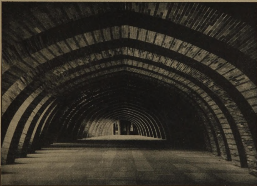
Abb. 16. Große Vor- oder Wandelhalle. (Vgl. Grundriß Abb. 4, S. 450.) Abb. 14—16. Einzelheiten vom Planetarium. Arch. Prof. Wilh. Kreis. Die neue Baugruppe am Rheinufer zu Düsseldorf.
