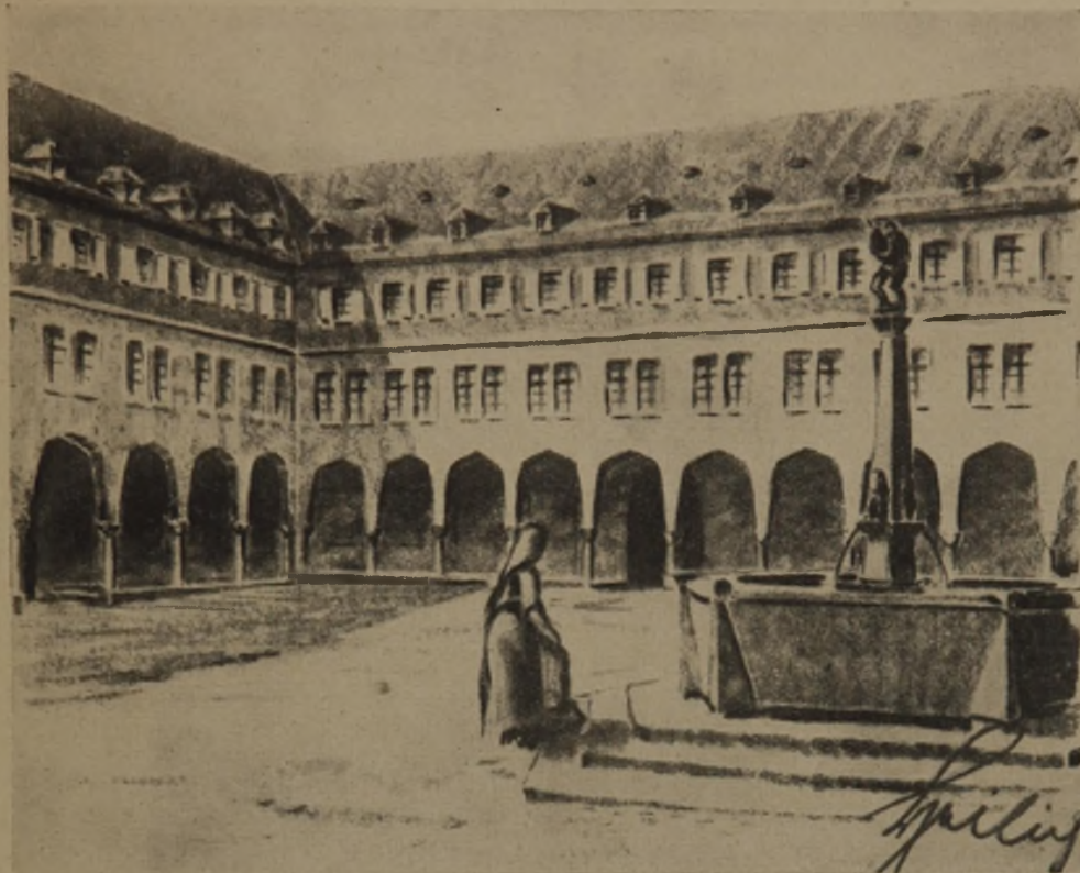
Abb. 6. Blick in den Winkel von West und Ostseite des Platzes.
