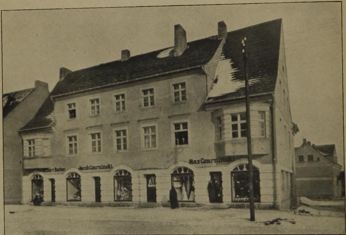
Abb. 26. Haus Czarninski, Prostken. Bauleitung: Arch. Ignaz Porth unter Mitwirkung der staatl. Bauberatung, Bez.-Arch. W. Brurein.
