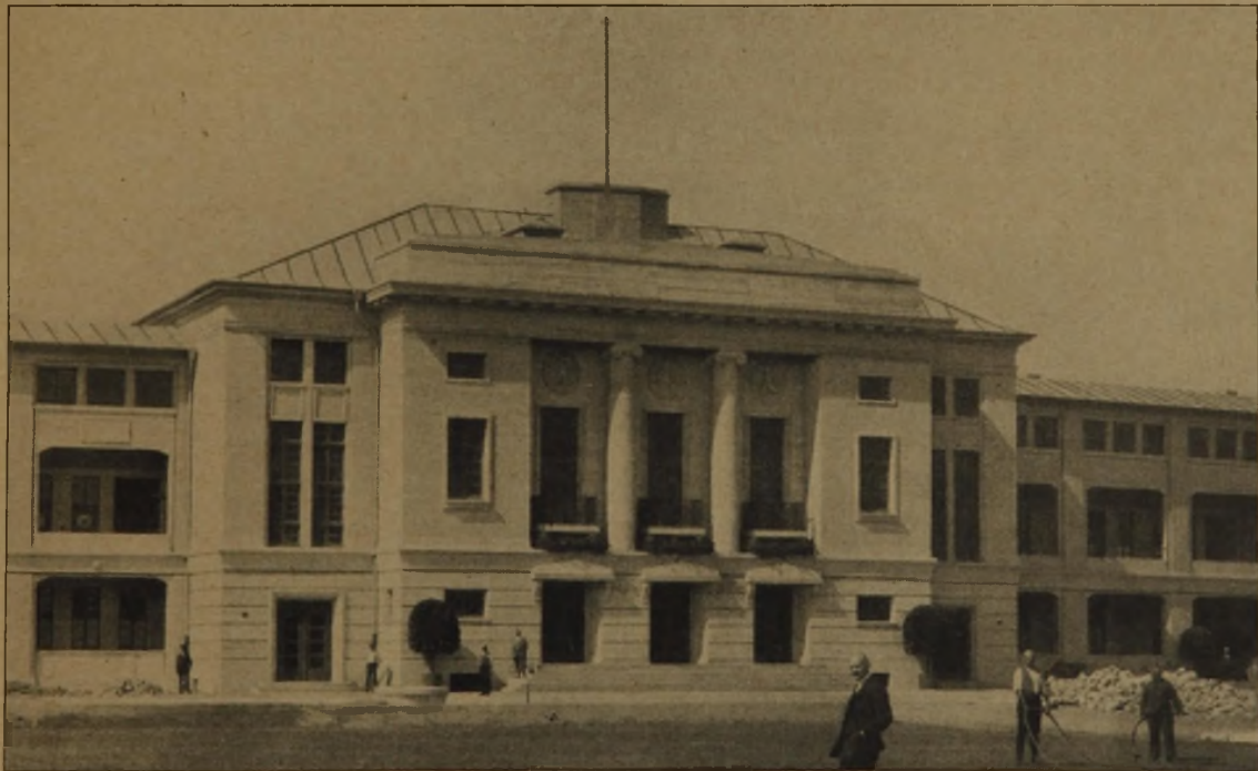
Abb. 11. Mittelbau des Tribünen- und Verwaltungsgebäudes. Nordseite.
