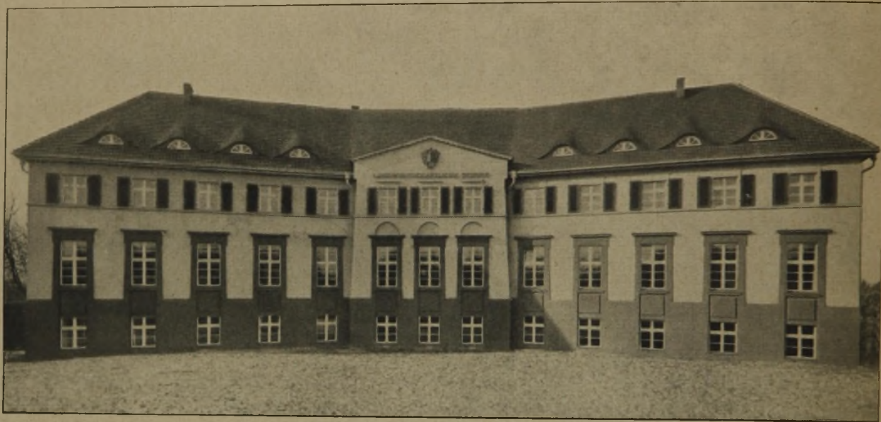
Abb. 1. Ansicht von der Gartenseite.
