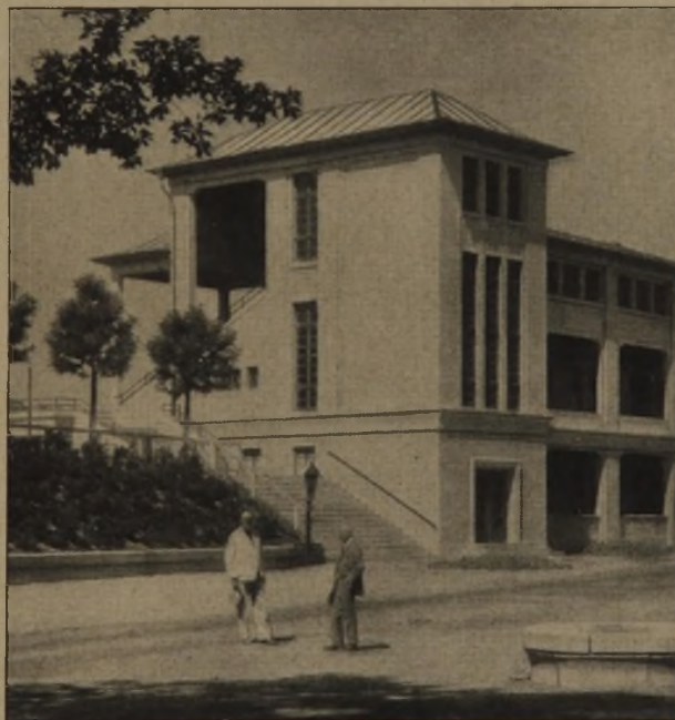
Abb. 9. Linker Aufgang zur Tribüne.
