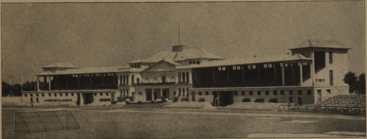
Abb. 8. Tribünen- und Verwaltungsgebäude. Ansicht von der Arena.
