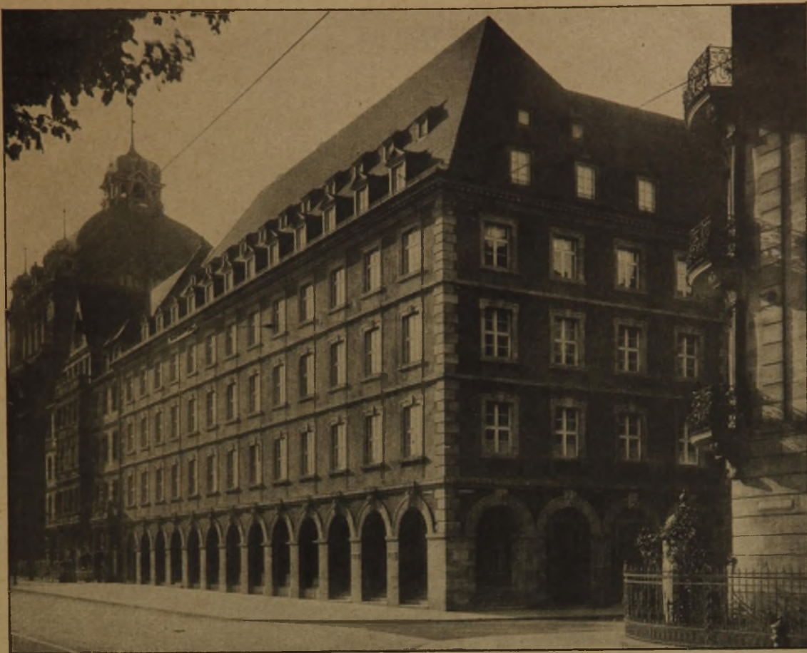
Abb. 9. Ansicht am Frauentorgraben.
