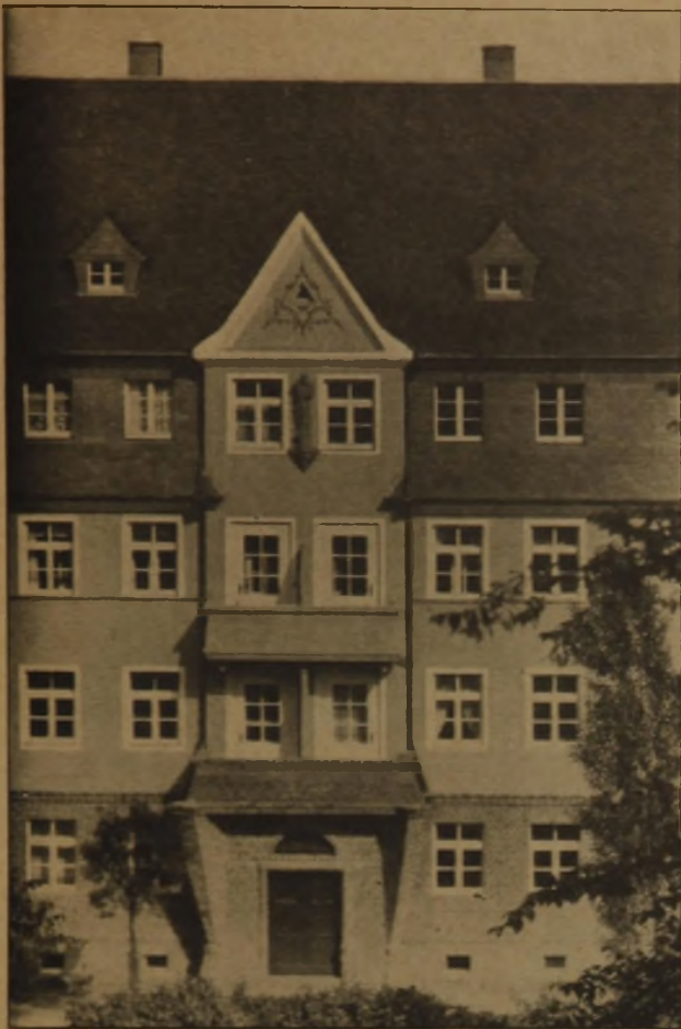
Abb. 6. Mittelstück der Hauptfassade.
