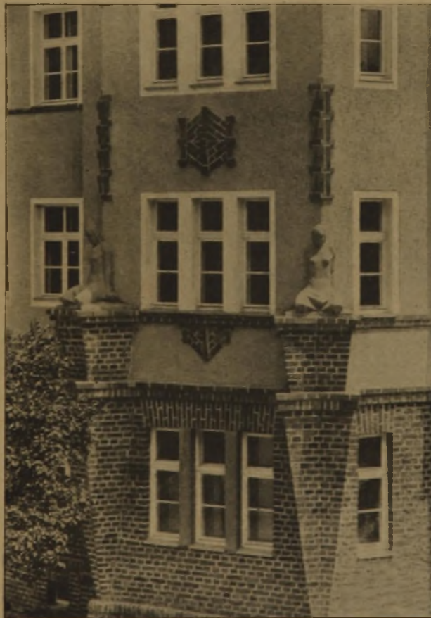
Abb. 8. Detail des Eckturmes Abb. 7. Entwurf und Bauleitung: Landessiedlungs- und Wohnungsfürsorge-Gesellschaft m. b. H. „Sächsisches Heim“. Arch: Reg.-Baurat Rud. Stegemann, Dresden.
