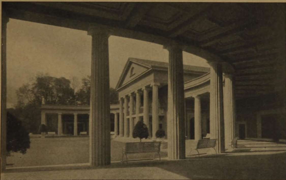
Abb. 13. Blick in die offene Trinkhalle. Die neue Trink- und Wandelhalle in Bad Oeynhausen.
