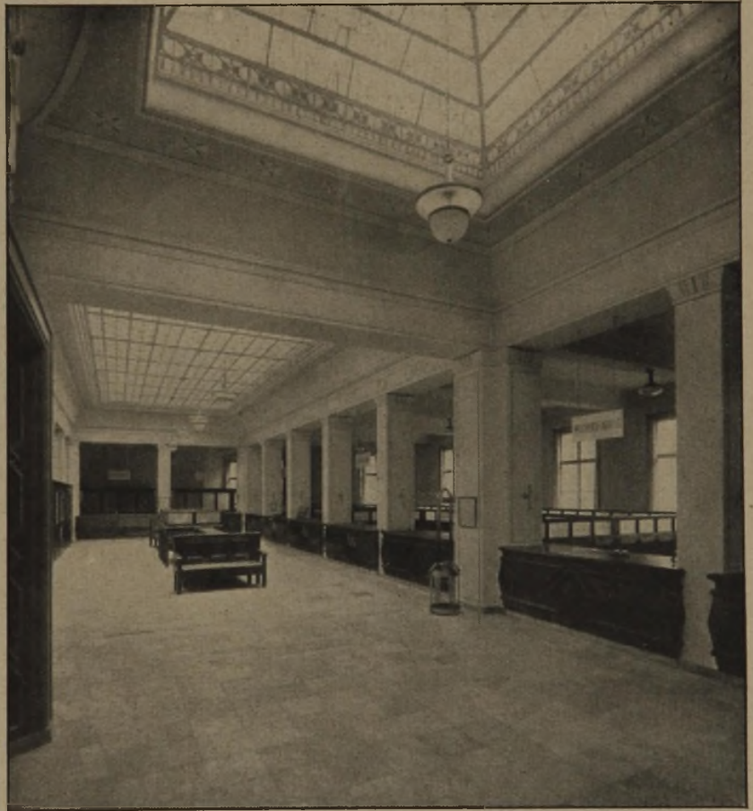
Abb. 17. Blick in den Kassensaal vom Eingang her.
