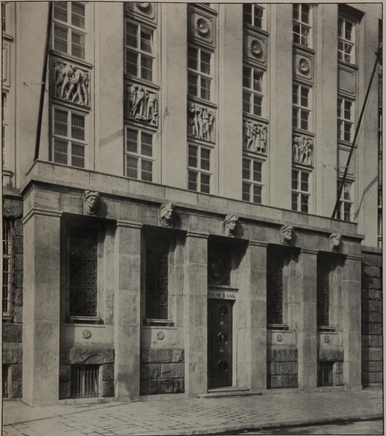
GESCHÄFTSGEBÄUDE DER DEUTSCHEN BANK IN CHEMNITZ EINZELHEIT DES MITTELRISALITS ARCHITEKT: ERICH BASARKE, CHEMNITZ DEUTSCHE BAUZEITUNG. LX. JAHRGANG 1926. NR. 69/70
