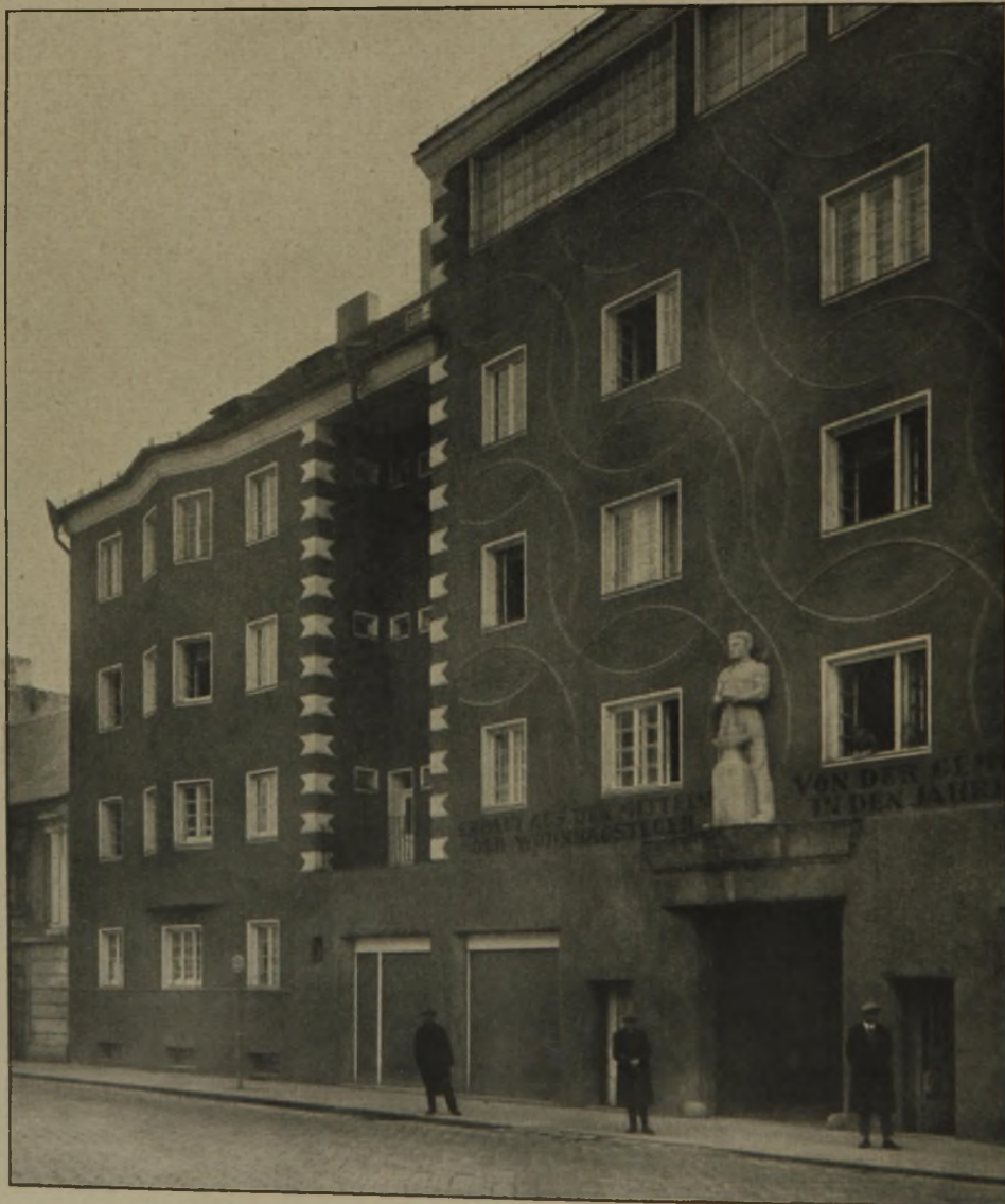
Abb. 5—9. Figureschmuck und Fassadenteil des Volkwohnhauses Philippsgasse. XIII. Bezirk in Wien. Arch. Z. V., B. D. A. Baurat Prof. Siegfried Theiß und Ziv.-Arch. Hans Jacksch.
