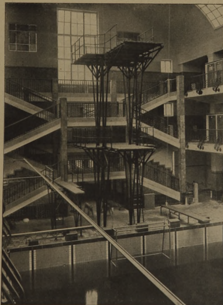
Abb. 5. Kopfende der Schwimmhalle mit Sprungerüst.
