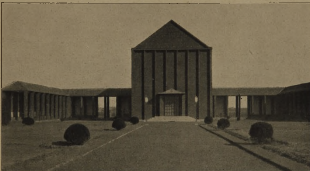
Abb. 1 (oben). Ansicht des Mittelbaus.
