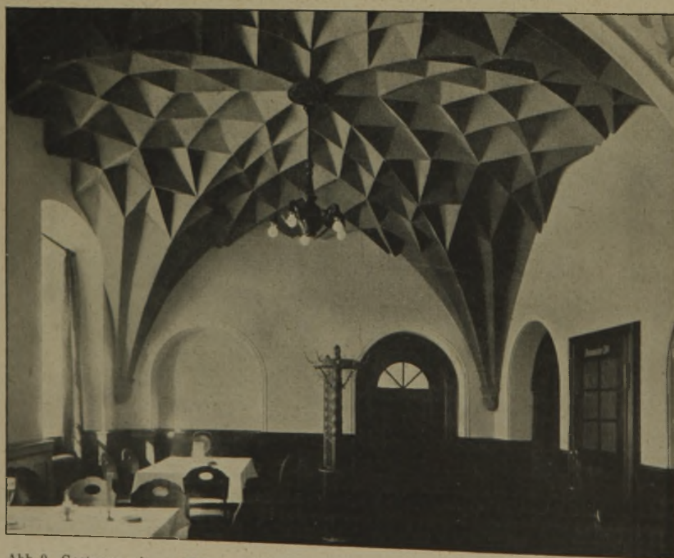
Abb. 9. Gastraum mit sog. Wabengewölbe a. d. 15. Jahrh. Der Umbau des Ratskellers zu Glogau.
