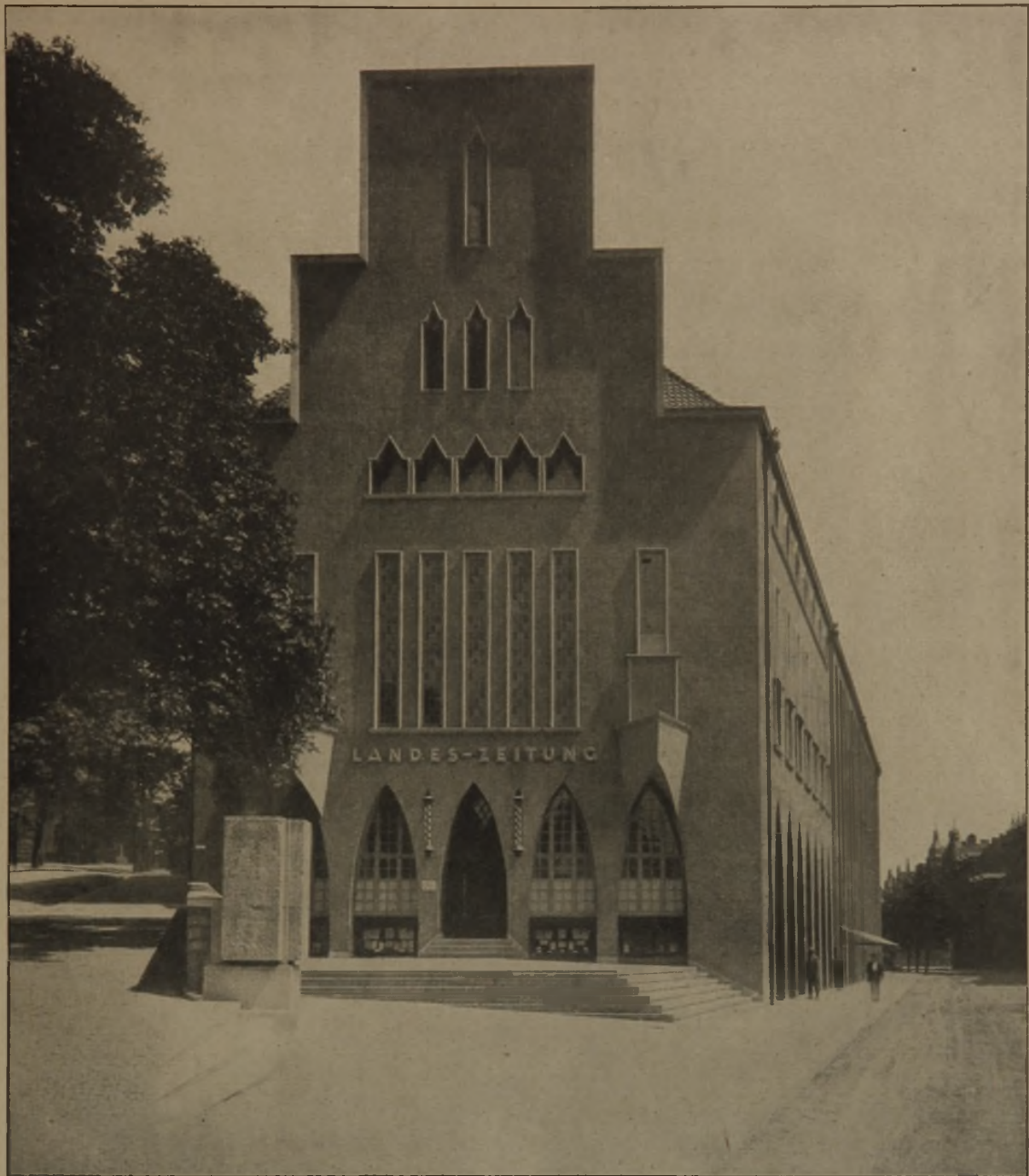
Abb. 3. Giebelansicht nach der Kaiserstraße.
