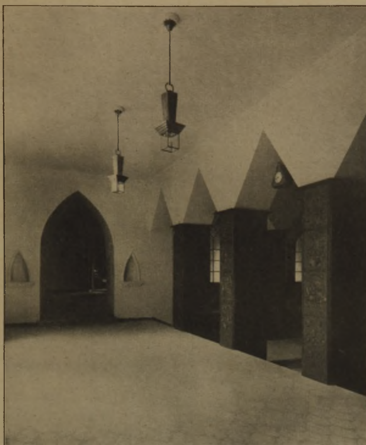
Abb. 7. Schalterhalle, oberer Teil.
