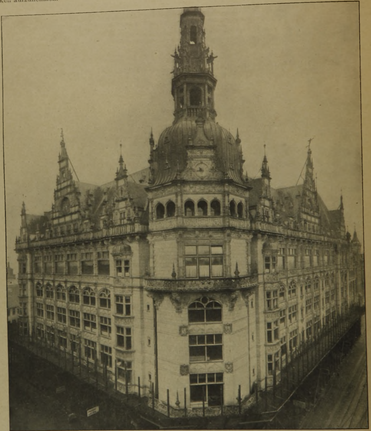
Abb. 2. Alte Hauptansicht vom Markt aus. Unterer Teil eingeschalt wegen der Schäden der Fassade.
