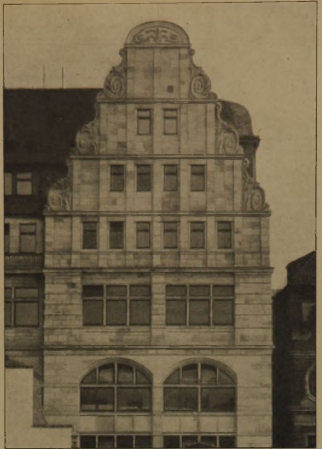
Abb. 10. Neue Fassade Wachtstraße mit Eckgiebel.
