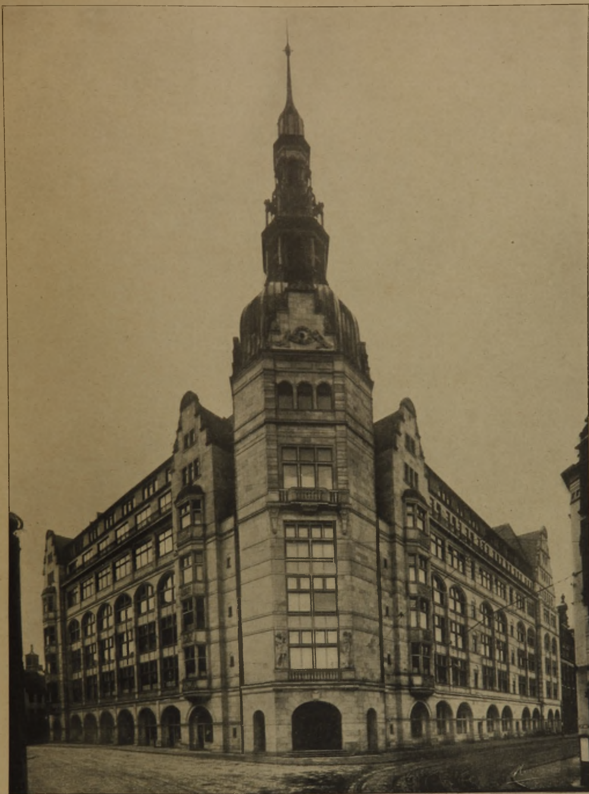
Abb. 3. Hauptansicht der Bremer Baumwollbörse nach dem Umbau.
