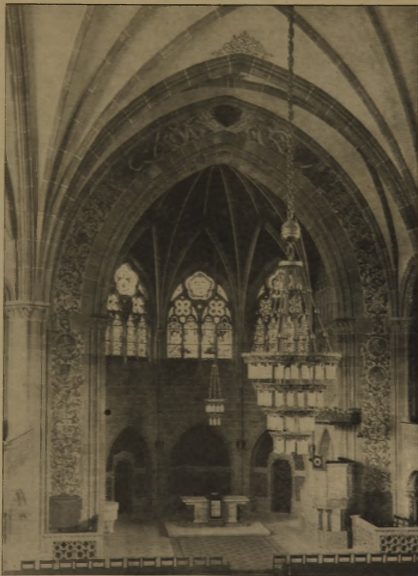
Abb. 1. Blick in den Chor. Reform. Kirche zu Detmold.
