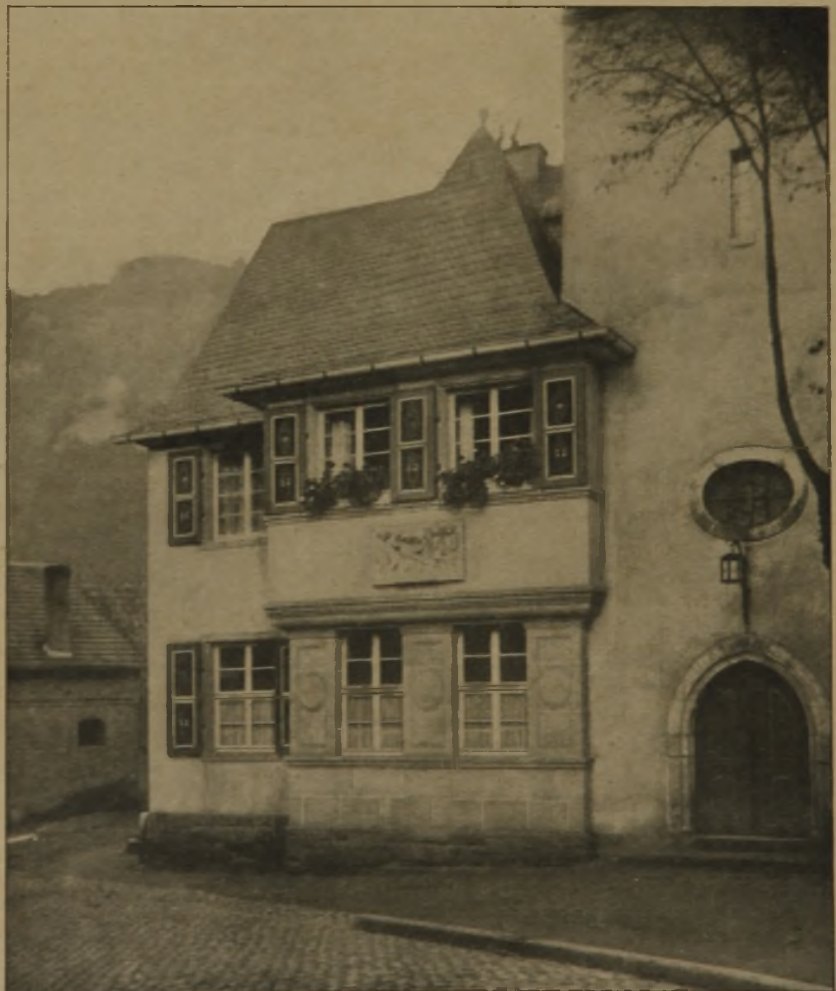
Abb. 15. Gemeindehaus in Münster a. St. am Turme der i. übr. abgebrochenen alten Kirche.
