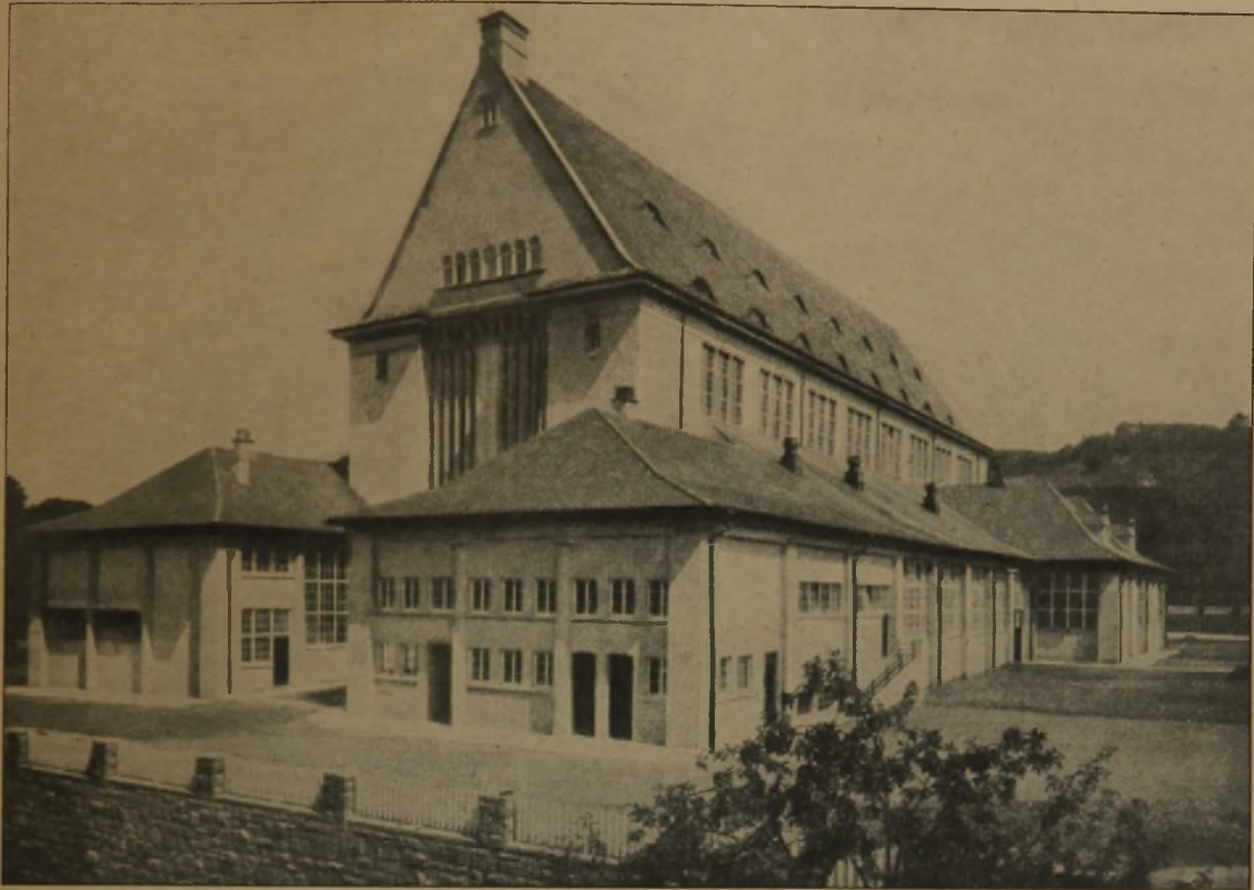
Abb. 8. Westansicht des Hauptgebäudes.
