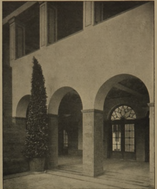
Abb. 12. Ecke aus der Treppenhalle.
