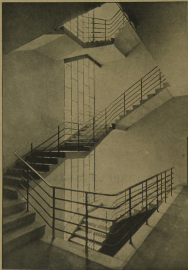
Abb. 8. Blick in das Treppenhaus.
