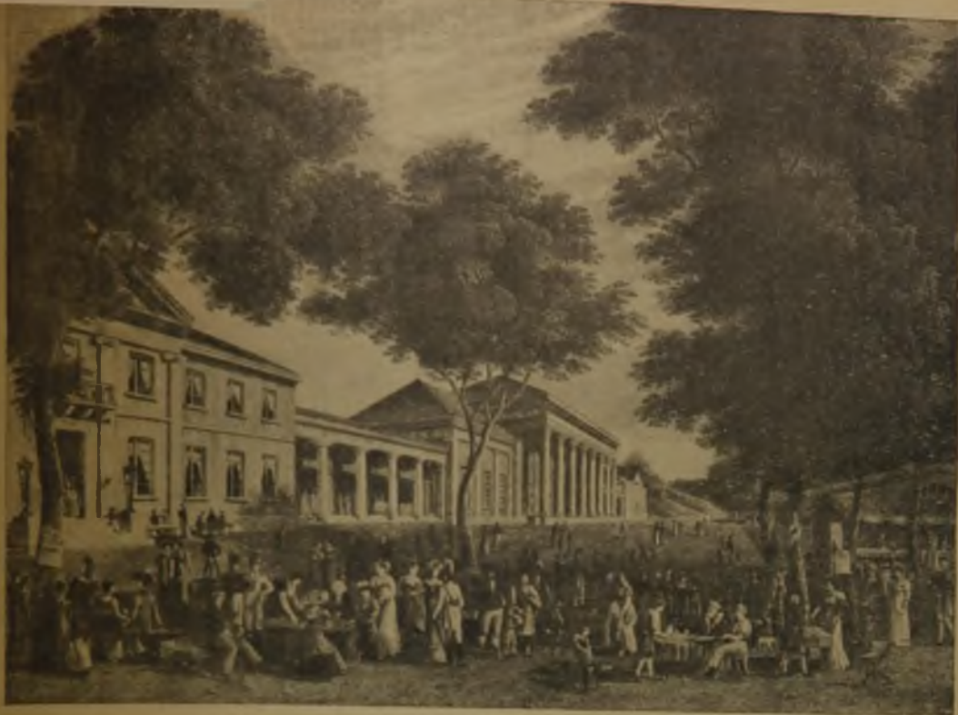
Das Konversationshaus von Friedrich Weinbrenner in Baden-Baden. Die Um- und Erweiterungsbauten des Kurhauses in Baden-Baden.
