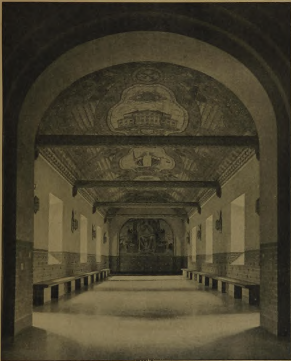
Mittel-Galerie im ersten Obergeschoß des Rathauses von Stockholm. Architekt: Carl Westman in Stockholm.
