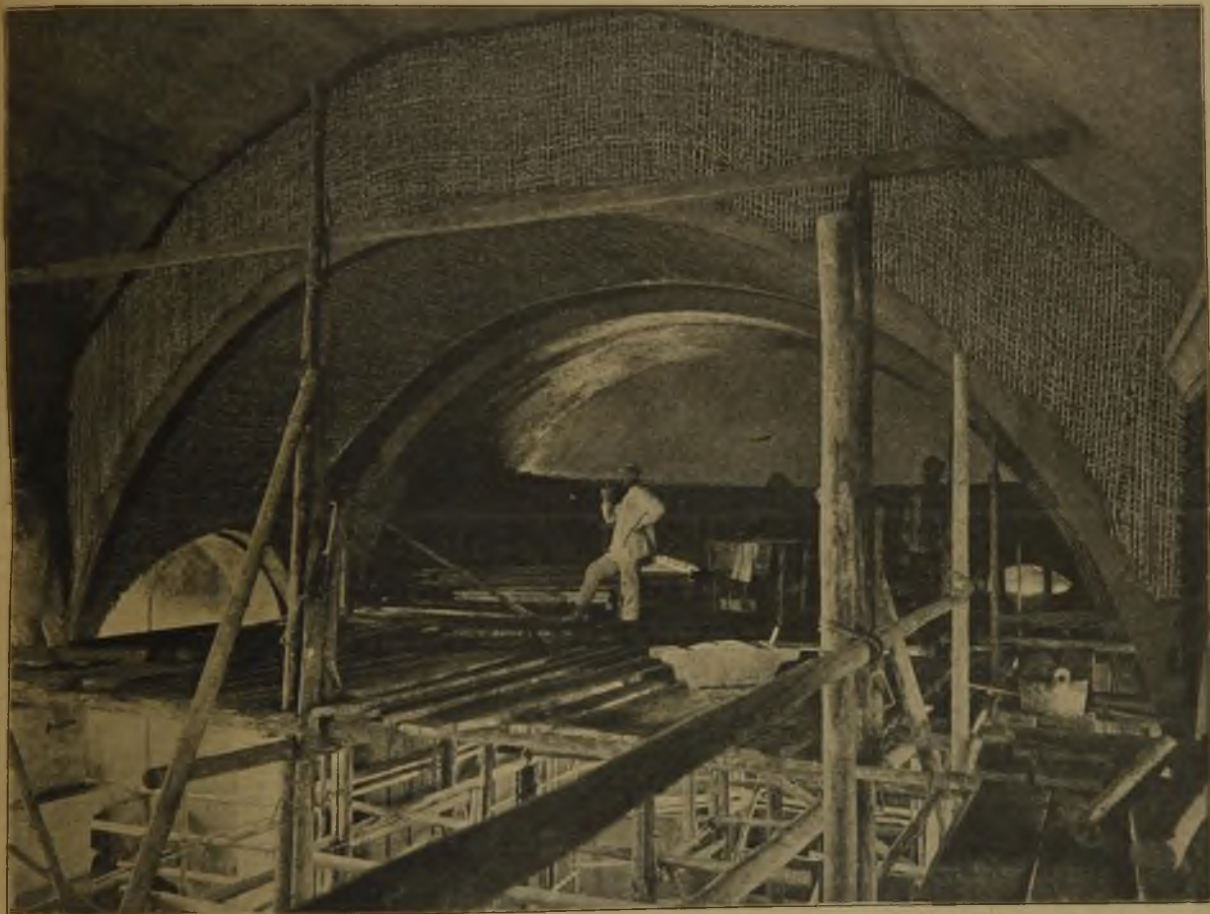
Herstellung eines Kirchengewölbes mit Hilfe von Sola-Gewebe.
