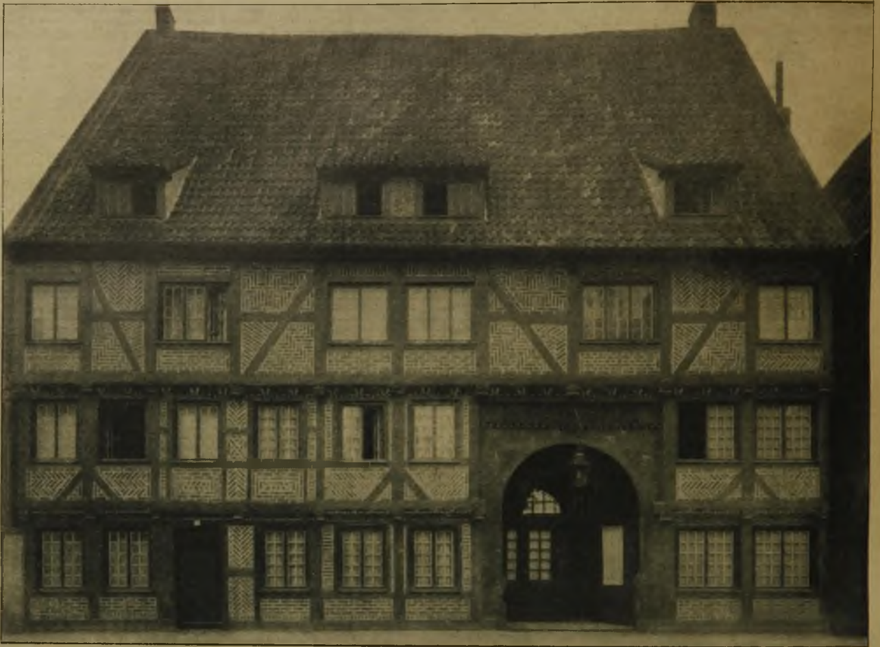
Fachwerkhaus Fleischhauer-Straße 16 in Lippstadt.
