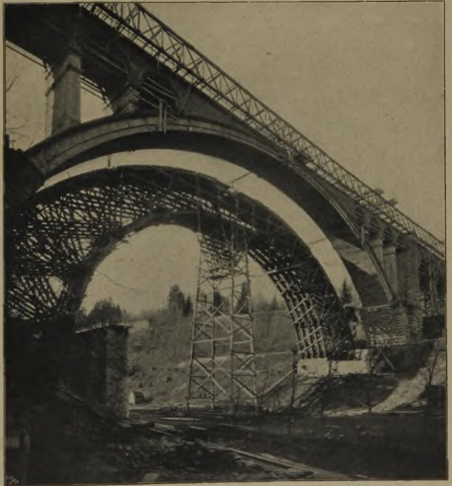
Lehrgerüst der Straßenbrücke über das Tal der Pétrusse in Luxemburg. Das Lehrgerüst des ausgerüsteten Bogens verschoben.
