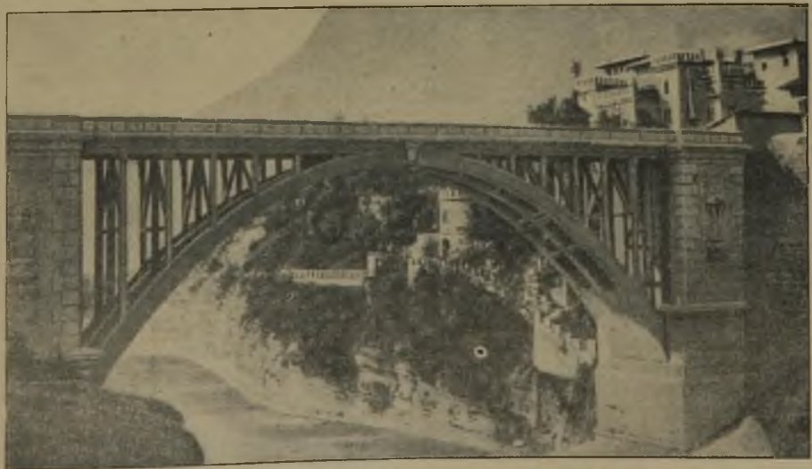
Abb. 1. Gesamtbild der Piave-Brücke.
