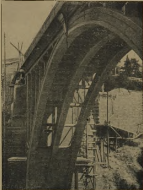
Abb. 2. Blick unter die Brücke.
