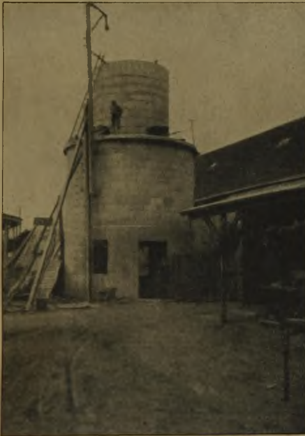
Abb. 18. Wasserbehälter mit Unterbau in der Ausführung.
