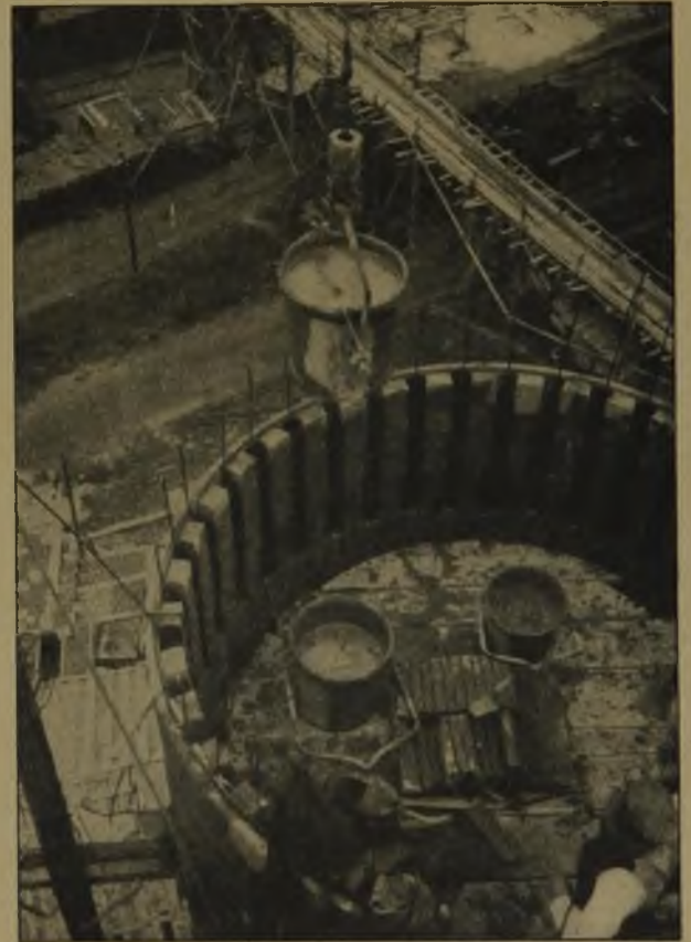
Abb. 15. Aufmauern der äußeren 2. Schicht und Einbringen des Betons.
