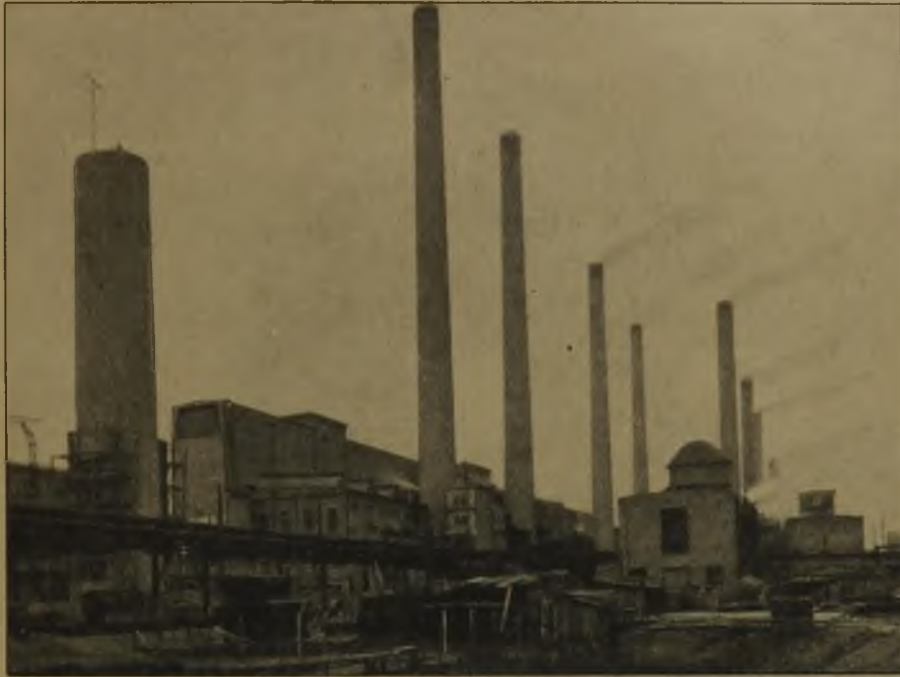
Abb. 17. Kamin von 125 m Höhe, 5,2 m ob. Durchm. im Bau mit Formsteinen System Lupescu.
