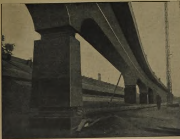
Abb. 3. Teilbild der Brückenanlage.
