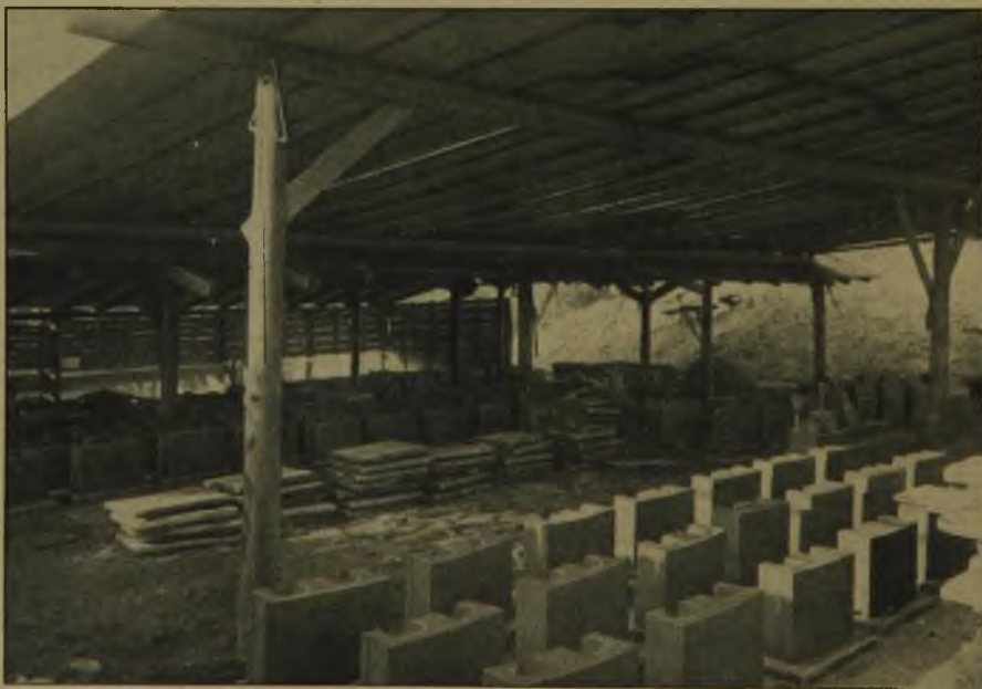
Abb. 7. Herstellung der Formsteine für den Turm. Kalkturmanlage in Aschaffenburg.
