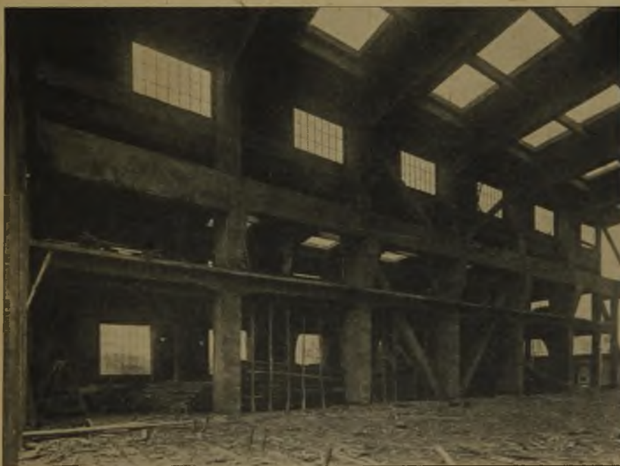
Abb. 4 u. 5. Blicke in die Halle im Bau.
