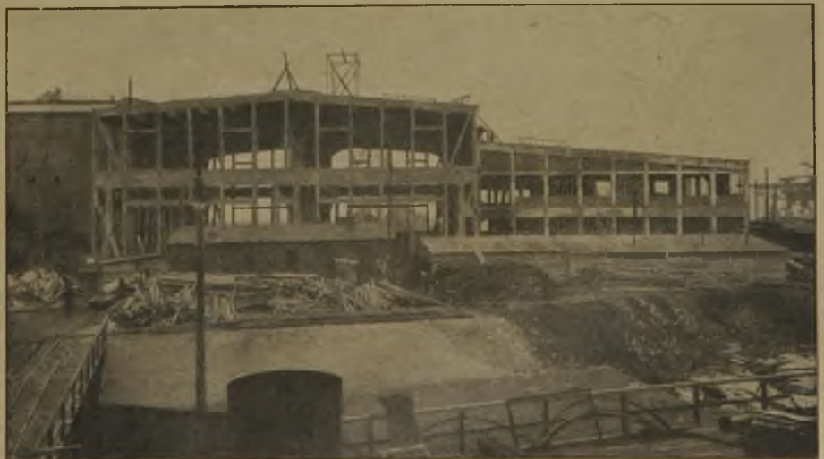
Abb. 6. Vorderansicht des Baues während der Herstellung.
