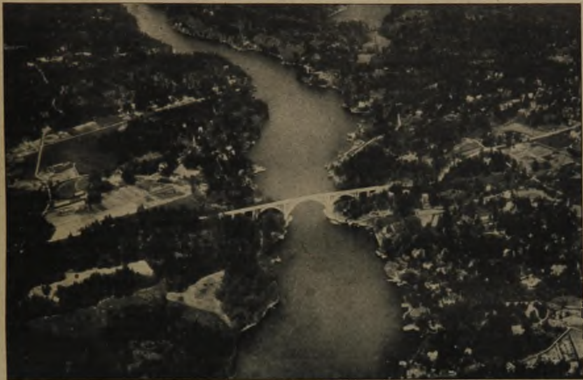
Abb. 2. Gesamterscheinung der Skuru-Sund-Brücke in der Landschaft (Luftbild). Bemerkenswerte Brückenbauten des Auslandes in Beton und Eisenbeton.
