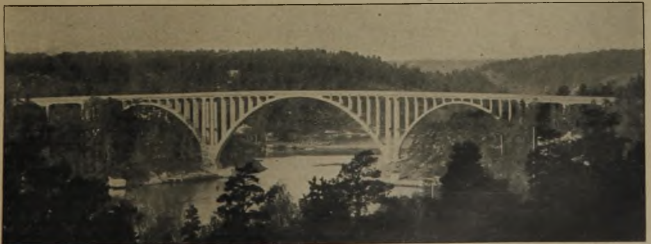
Abb. 1. Gesamtansicht des fertigen Brücken-Bauwerkes. (Mittelbogen 72 m Spw., Durchfahrtshöhe 32 m.)
