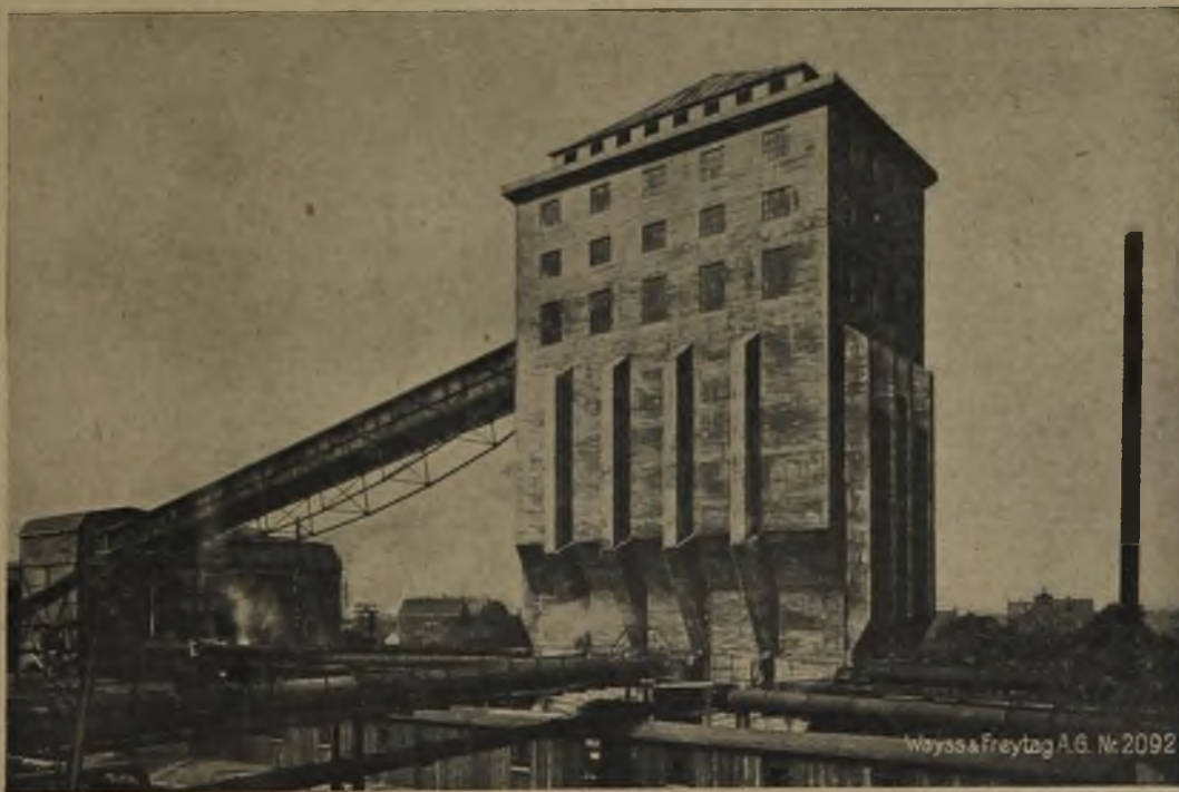
Abb. 5. Ansicht des Kokskohlenturms mit Transportbrücke. Architektonische Ausgestaltung von Professor Wilh. Kreis, Düsseldorf.
