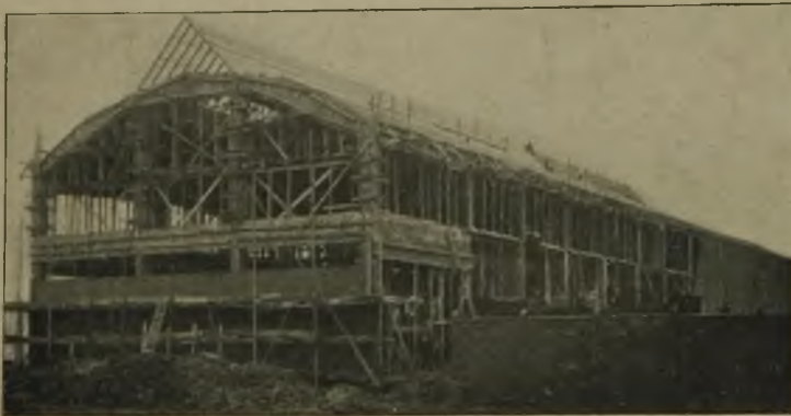
Abb. 6. Halle in der Ausführung. (Im Rohbau nahezu fertig).
