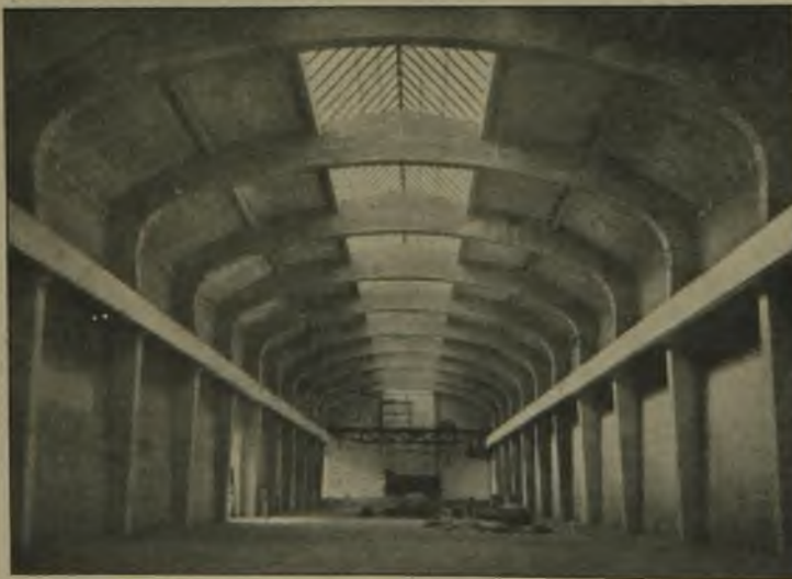
Abb. 7. Blick in die fertige Halle.
