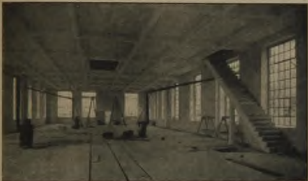
Abb. 6 (oben). Dachkonstruktion mit aufgestellter Schalung.
