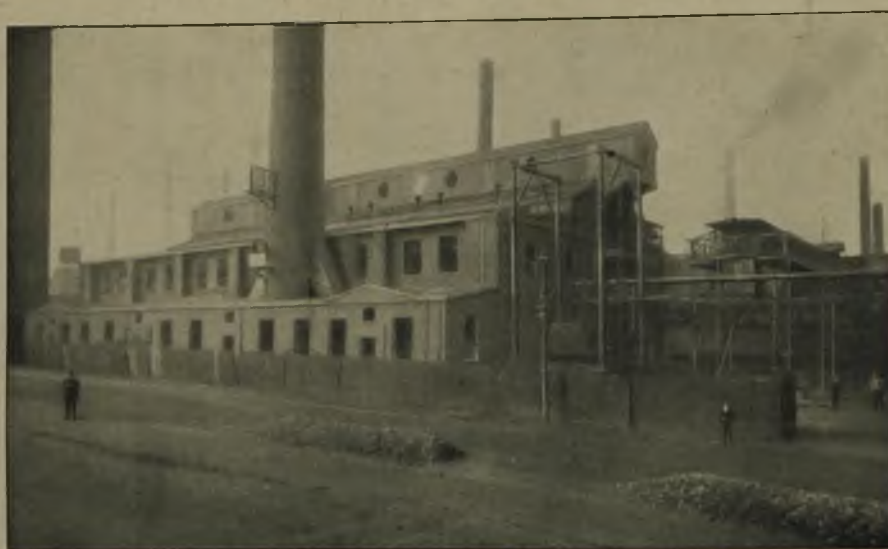
Abb. 7 Blick auf das fertige Kesselhaus.
