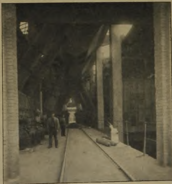
Abb. 9. Blick in das Kesselhaus der Bismarckhütte zu Bochum unter die Kohlenbunker.
