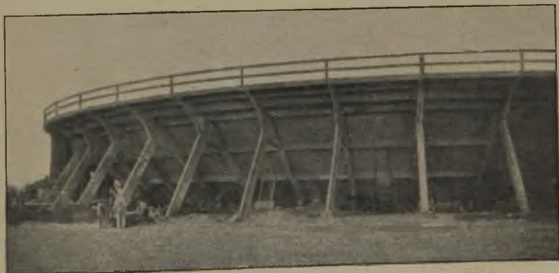
Abb. 3. Untersicht des erhöhten Endstückes der Bahn.
