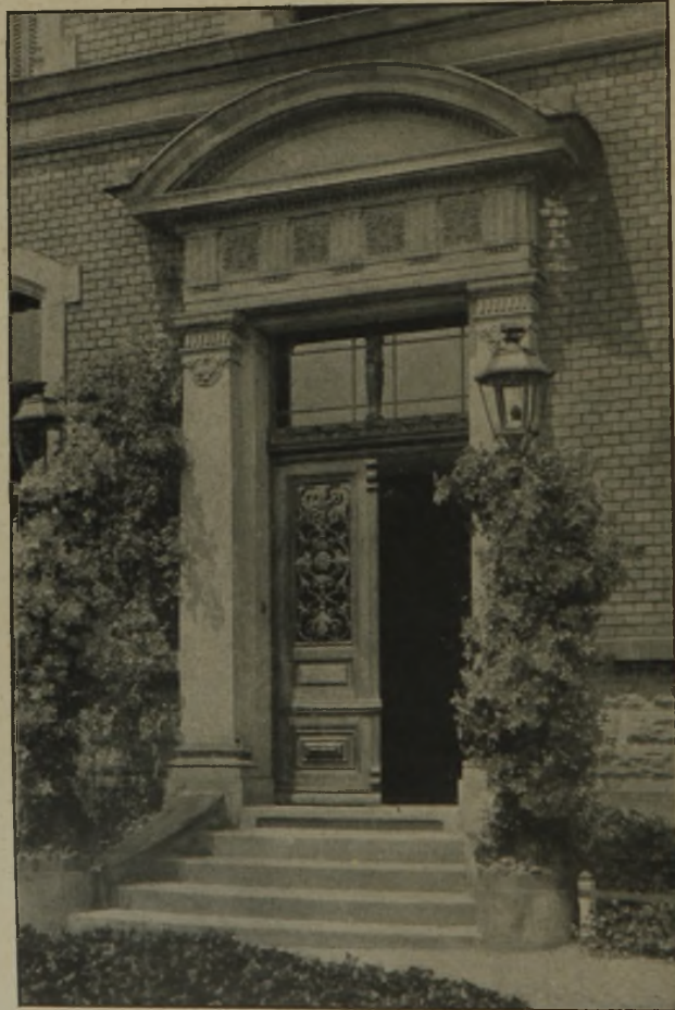
Abb. 3. Portal des Eisenbahnbetriebsinspektionsgebäudes auf Bahnhof Saargemünd.
