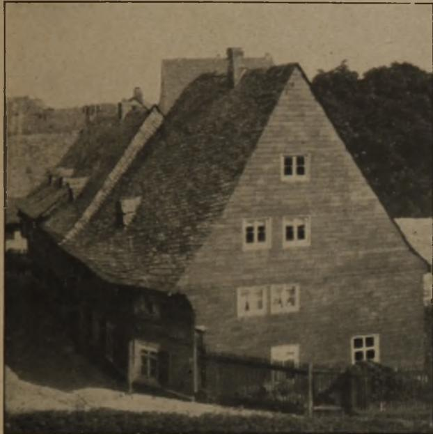
Abb. 2 (oben links). Häuser in Goslar i. Harz. Steiles Dach mit Schieferdeckung.
