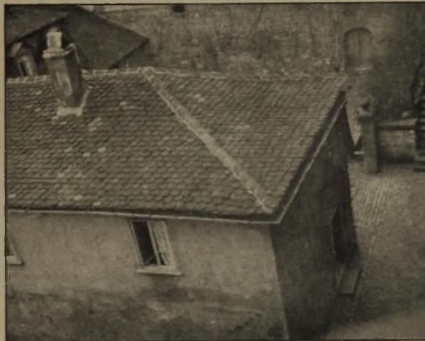
Abb. 4 (links). Eine außergewöhnlich flache Ziegeldeckung in Kassel (unterhalb des Theaters).
