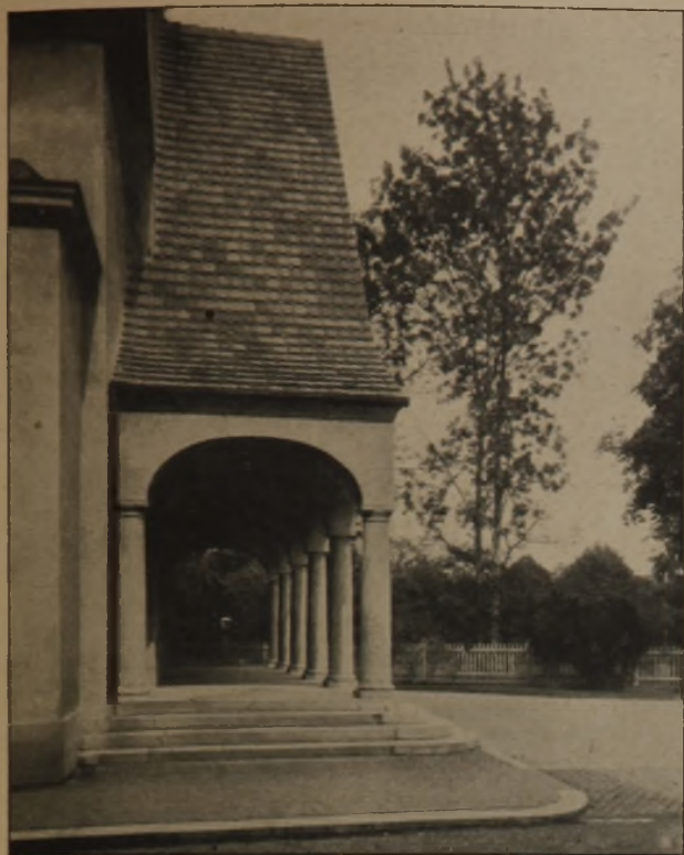
Abb. 9. Blick in die Vorhalle.
